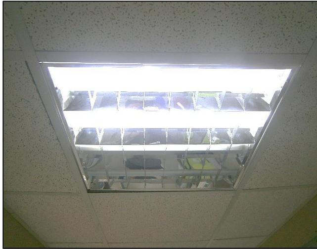
**Figura 46.** Propio (2018). Equipo de Rejilla empotrable de 4x18W c/u. donde la cuarta lámpara no está en funcionamiento. [Fotografía].
