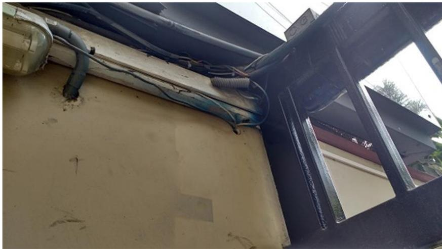
Figura 11 – Conductores en mal estado – riesgo eléctrico
