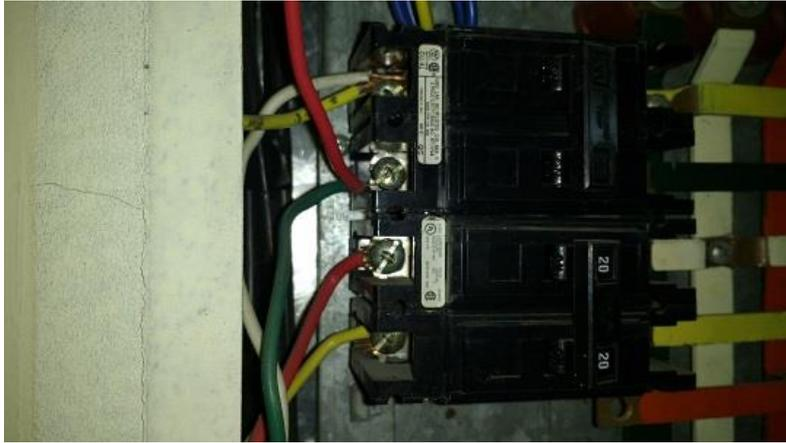
Figura 4 – Interruptores sin protección mecánica – riesgo eléctrico
