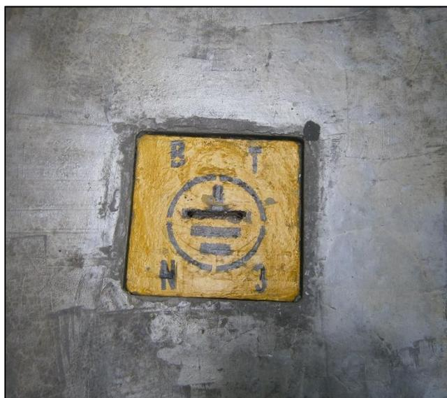
**Figura 50.** Propio (2018). Sistema de Puesta a tierra del medidor eléctrico dentro de una caja de registro de concreto de tapa color amarillo ubicado en el piso cerca al jardín. [Fotografía].
