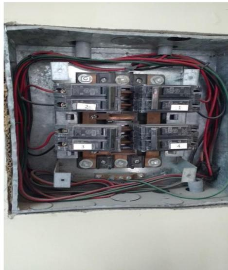
Figura 7 – Conductores no normados
