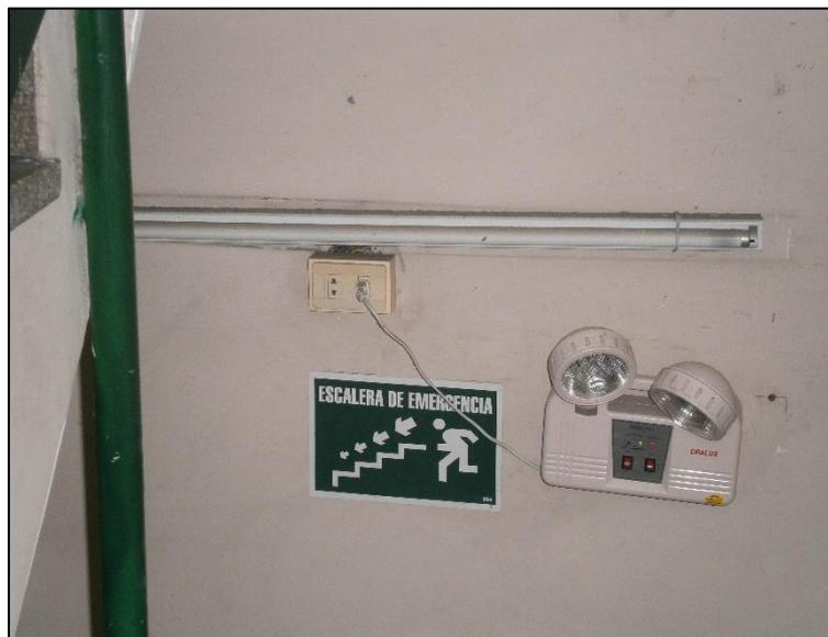
**Figura 49.** Propio (2018). Luz de Emergencia de marca Opalux con tomacorriente doble sin conexión a tierra ubicado en las escaleras de emergencia del tercer piso del Edificio COFOPRI. [Fotografía].
