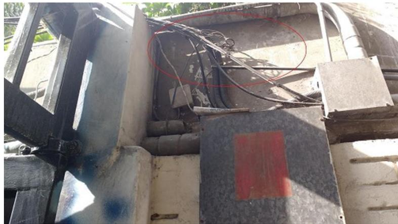
Figura 10 – Conductores sin canalizar
