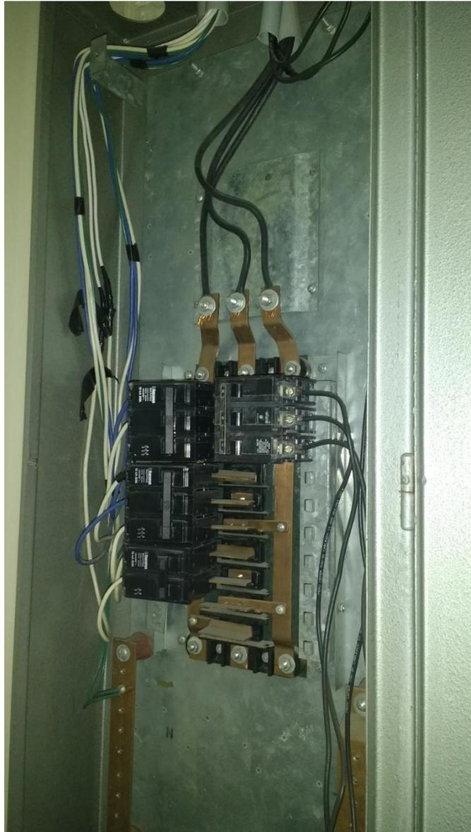
Figura 3 – Conductores eléctricos expuestos
