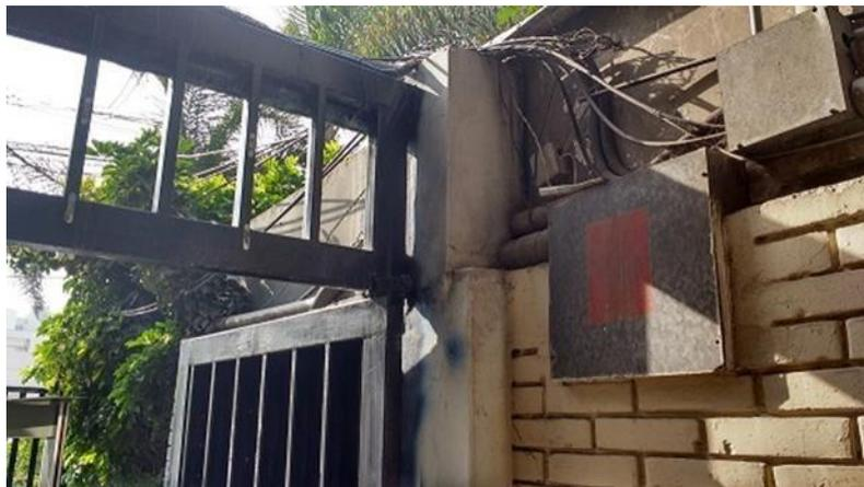
Figura 4 – Conductores eléctricos en mal estado
