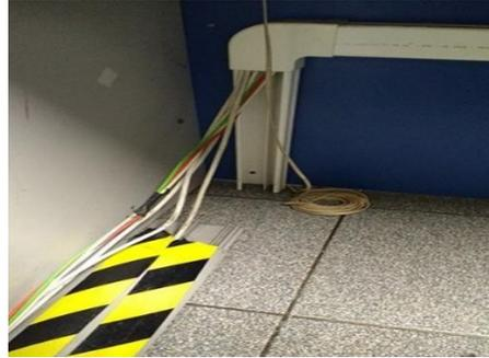
Figura 2 – Conductores empalmados
