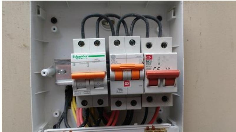
Figura 2 – Interruptores con doble circuito
