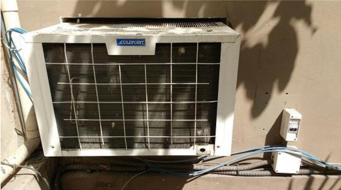
Figura 5 – Sistema de conductoras inadecuadas. Riesgo eléctrico
