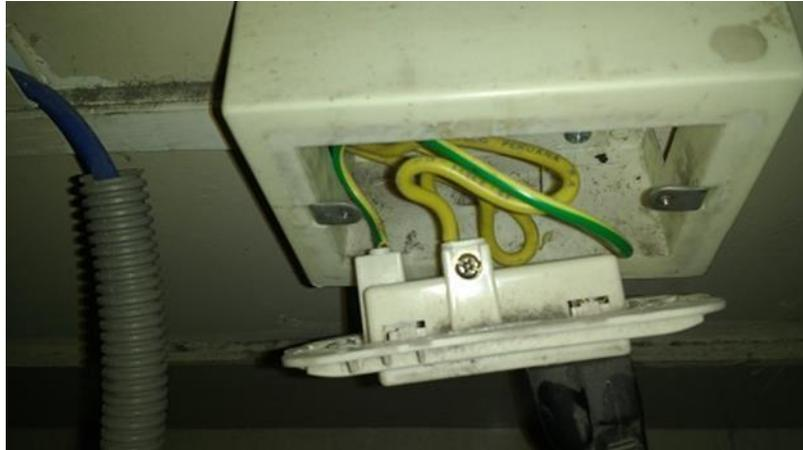
Figura 6 – Conductores sin terminales, sin codificación por colores
