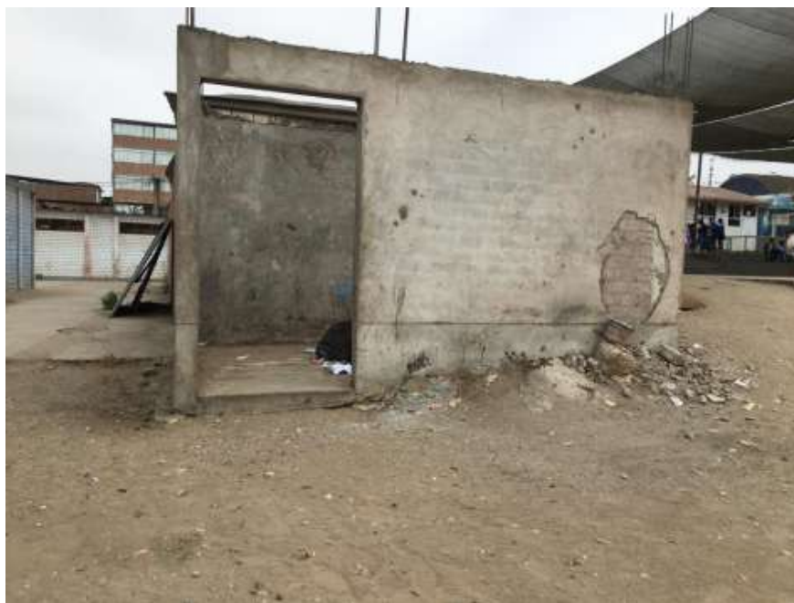
Figura 24. Punto de acopio central de residuos sólidos de la Institución Educativa N°6069 PACHACUTEC
