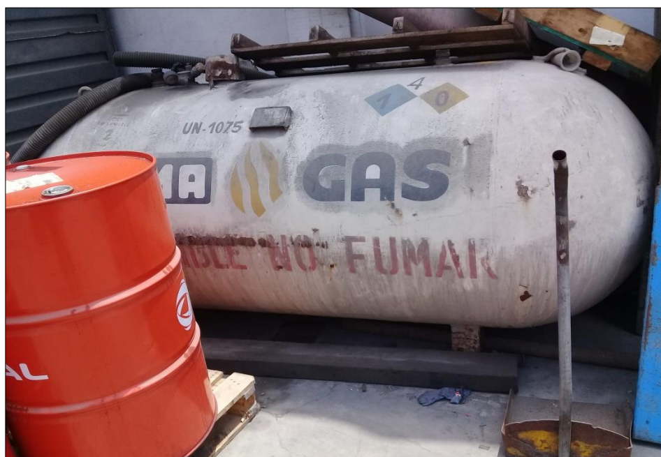
Anexo 6: Gas combustible almacenado sin cuidado con otros residuos peligrosos
