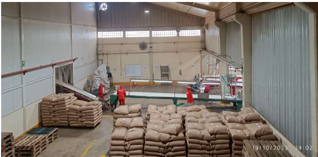
Figura 17: Vista actual, después de la instalación de la faja
