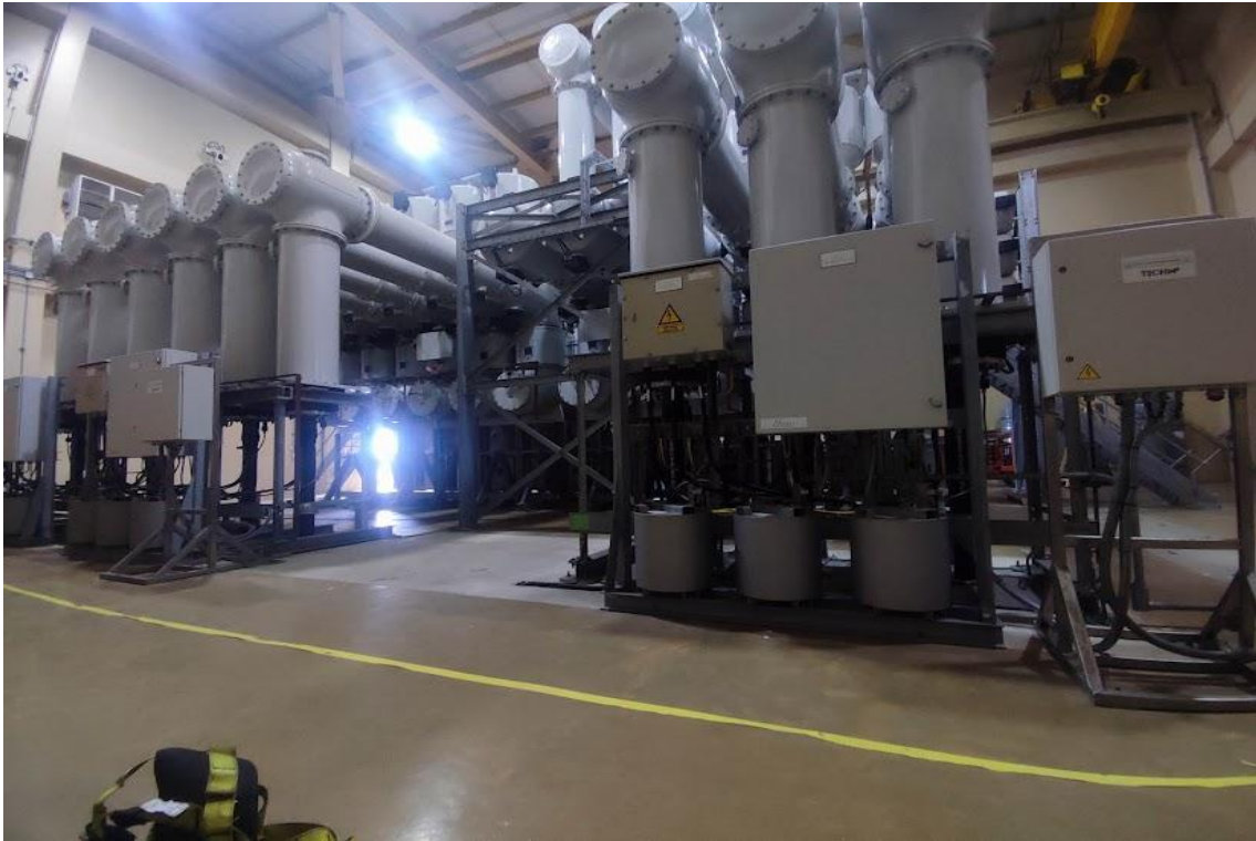
Figura 4 Subestación GIS
