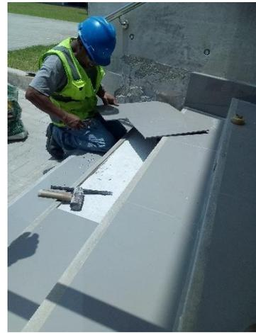
Imagen 15. Corte de mayólicas. Falta de uso de EPP's.
