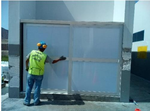
Imagen 1. Instalación de puerta de policarbonato, con uso de EPPs
