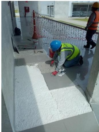
Imagen 14. Enchapado de piso y escaleras con uso de EPPs.
