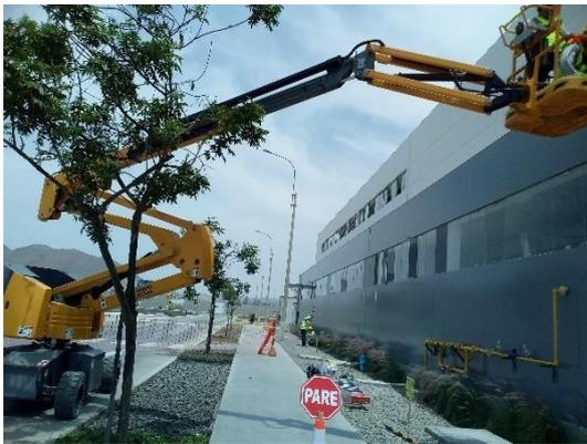
Imagen 6. Pintado de paredes y vía peatonal. Capacitación obligatoria en trabajos de alto riesgo, uso de EPPs y procedimientos de trabajo con manlift.
