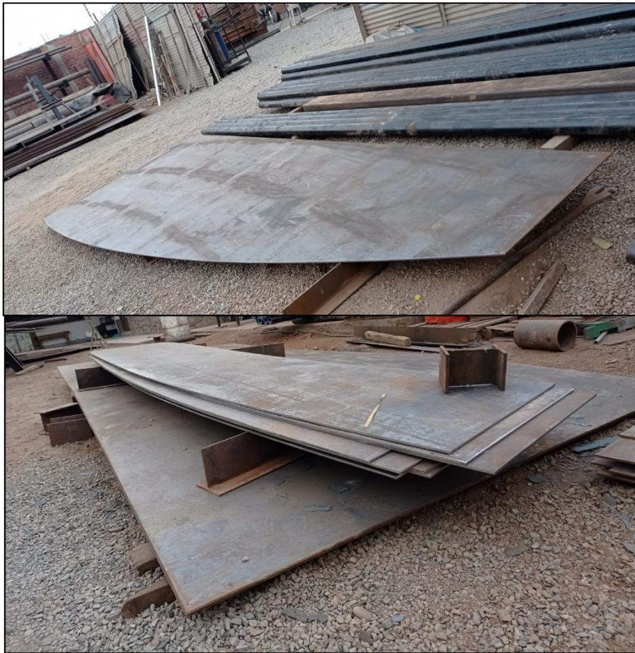
Figura 15: *Habilitado de Planchas de Fondo y para Anillo Anular.*
