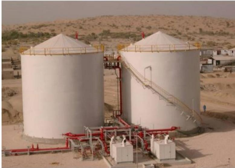
Figura 8: *Tanques de Almacenamiento con techo cónico.*
