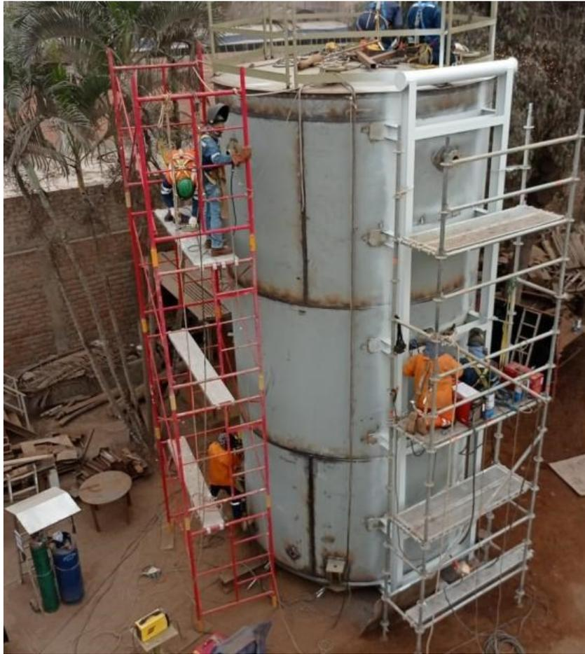
Figura 13: Montaje de Tanques en taller.
