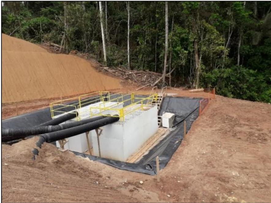
Figura 5: Tanques Bajo Tierra.
