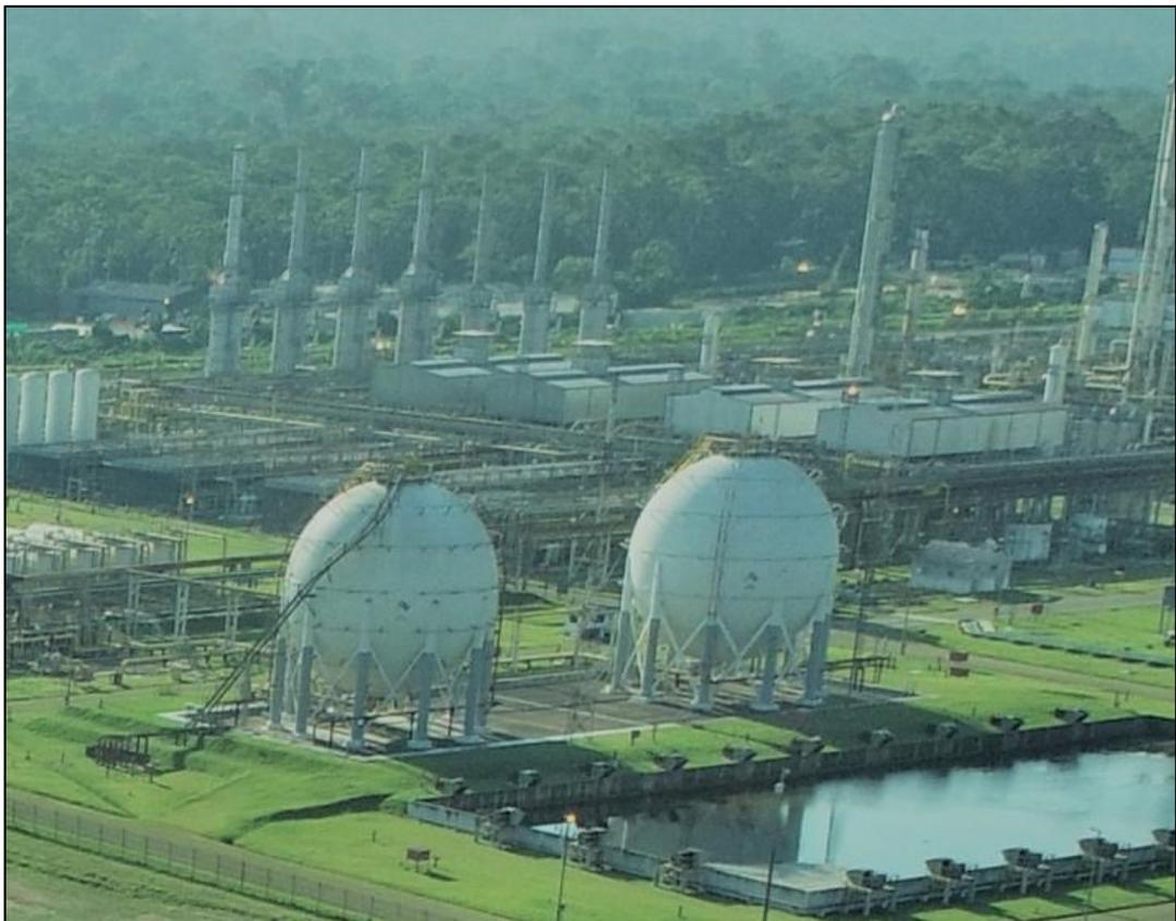
Figura 10: *Tanques de Almacenamiento de Alta Presión.*
