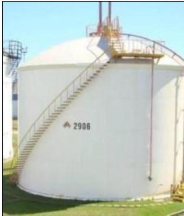
Figura 9: *Tanques de Almacenamiento con techo tipo Domo.*
