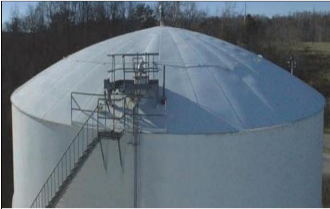
Figura 11: *Tanque de Techo Fijo.*
