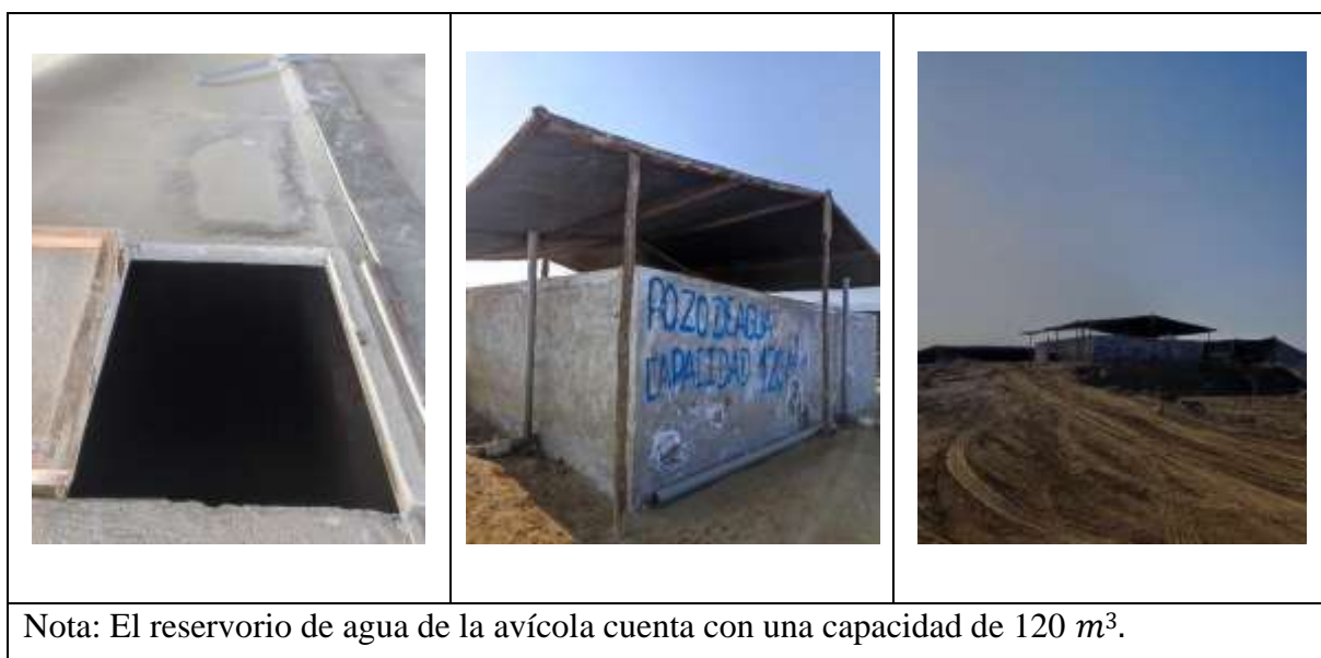
Reservorio de agua de avícola AJI SECO SAC
