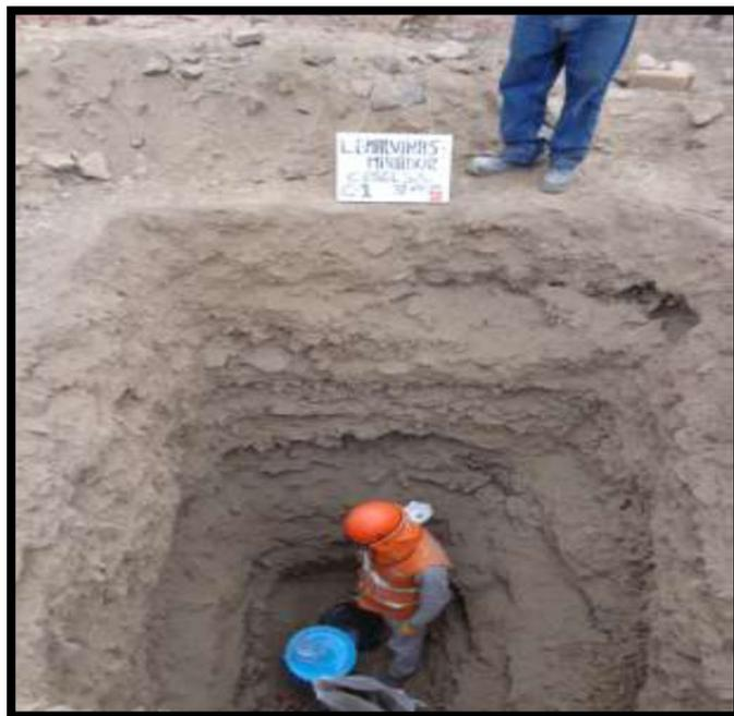
**FIGURA N° 10: VISTA DE PERFIL MOSTRANDO LA CALICATA C-1.**
