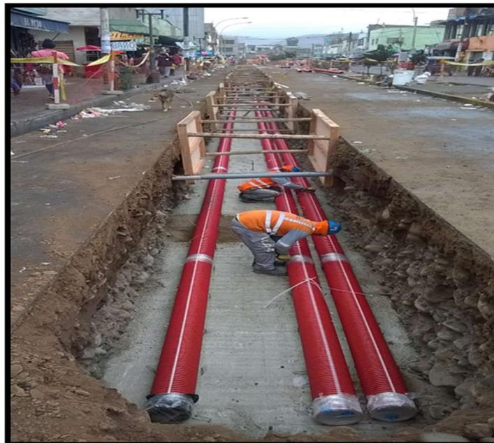
**FIGURA N°01: VISTA DE UNA LINEA SUBTERRÁNEA.**
