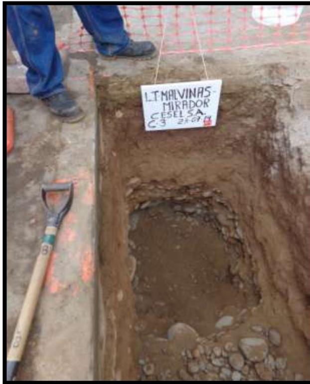
FIGURA. N°12: VISTA DE PERFIL MOSTRANDO LA CALICATA C-3.
