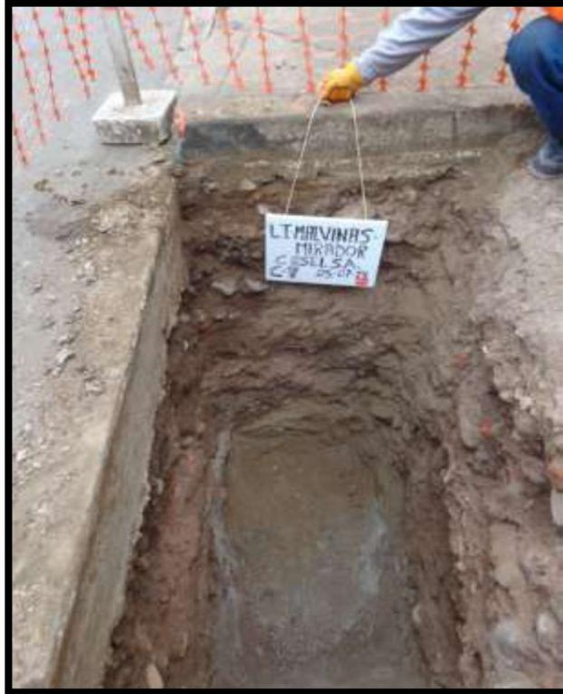
FIGURA. N°16: VISTA DE PERFIL MOSTRANDO LA CALICATA C-7.
