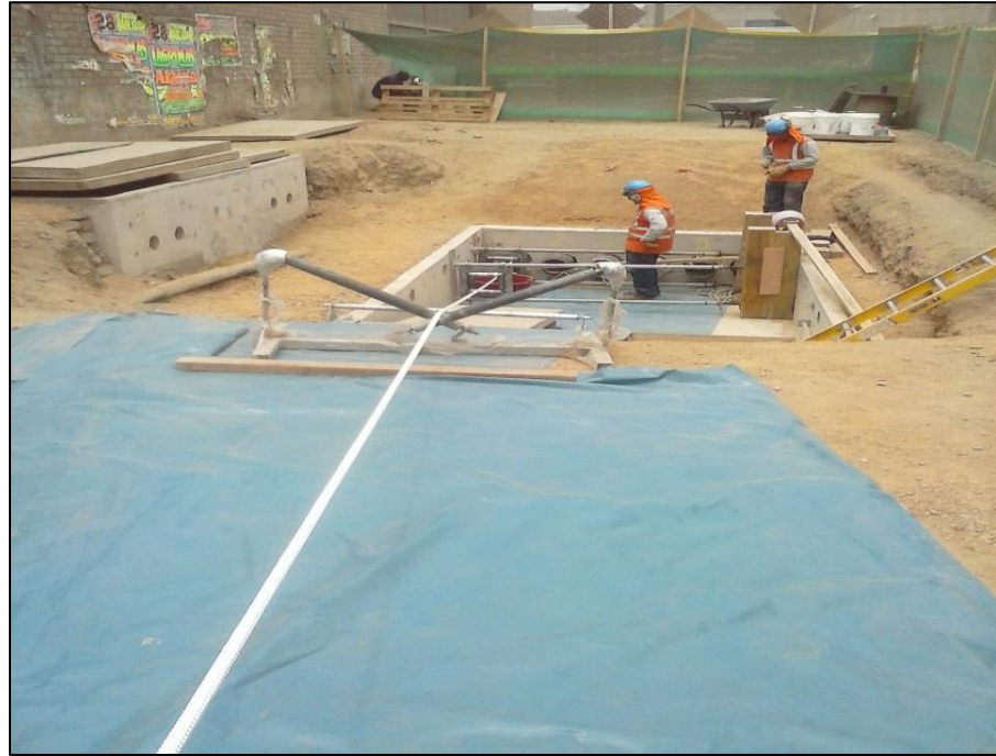
Figura 19. Limpieza de ductos.
