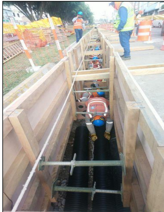
Figura 5. Canalización Entubado en zanja.
