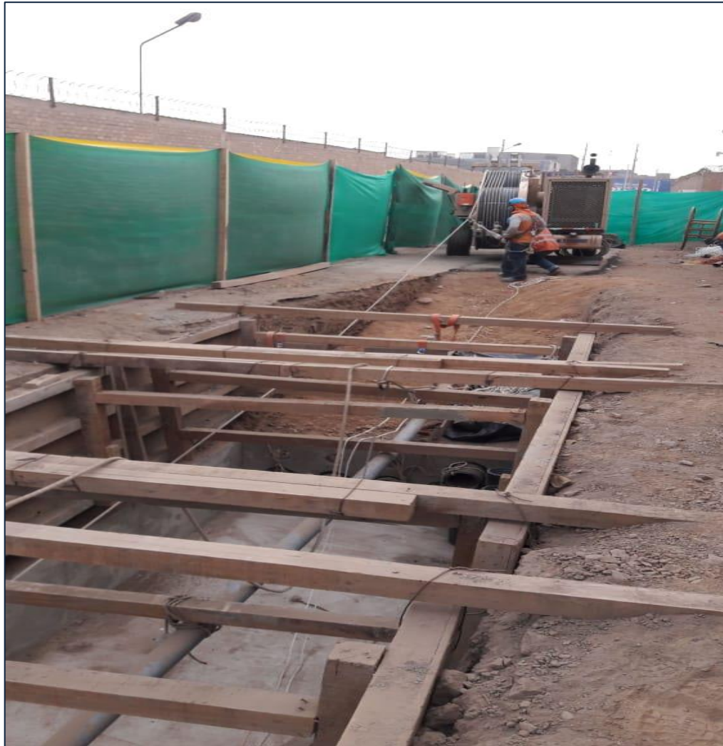
Figura 2. Línea de transmisión subterránea.
