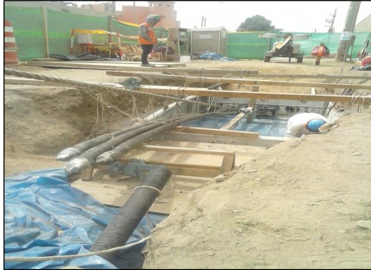
Figura 32. Tendido de cable de energía.
