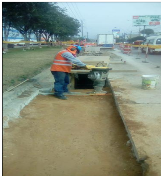
Figura 13. Relleno y compactación.
