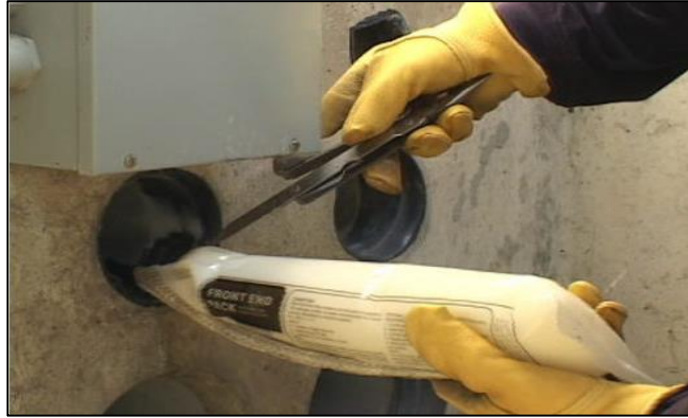
Figura 25. Lubricado de ducto con polywater.
