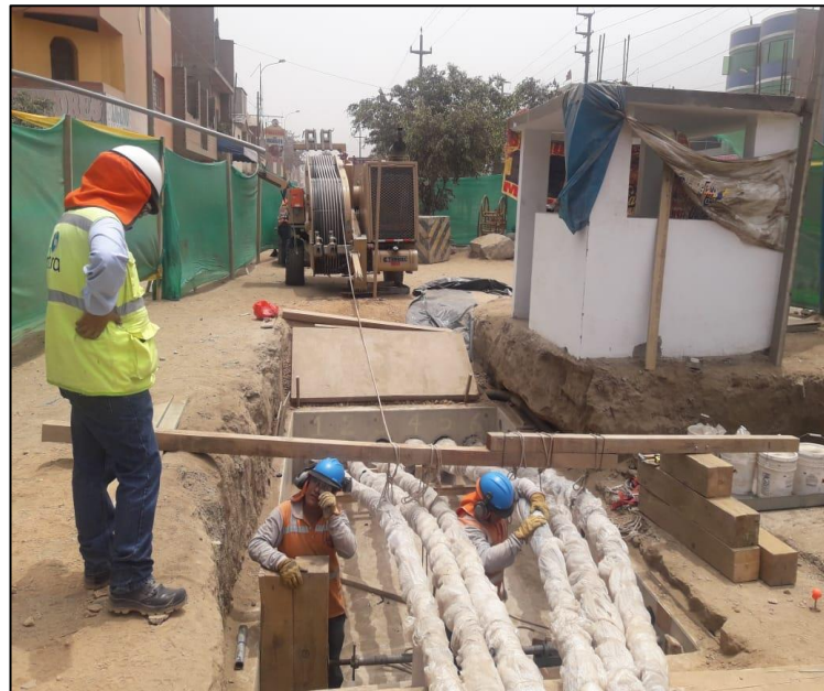
Figura 32. Tendido de cable de energía.
