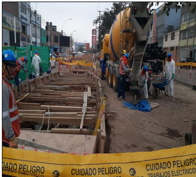
Figura 11. Vaciado de concreto 100 kg/cm 2 en banco ducto.
