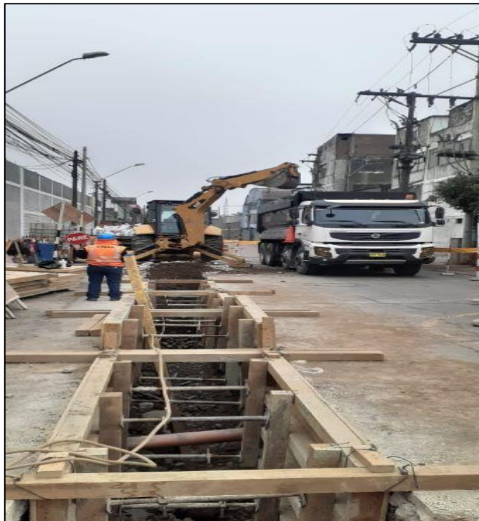
Figura 9. Excavación con máquina retroexcavadora.
