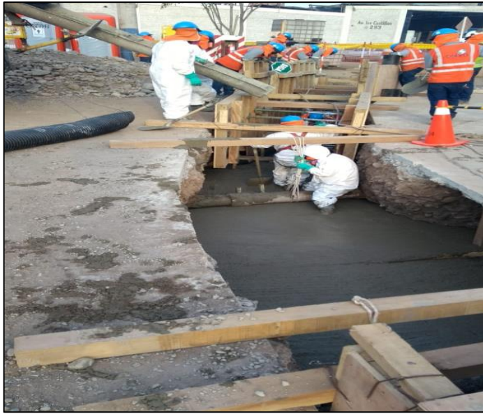
Figura 11. Vaciado de concreto 100 kg/cm 2 en banco ducto.
