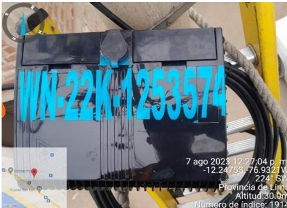
En la Figura 20 se aprecia como se realizan pruebas de intensidad en las CTO de la red para garantizar que la potencia se encuentre dentro del rango permitido por la empresa. La empresa tiene como lineamiento un rango de -10 dbm hasta -21 dbm.
