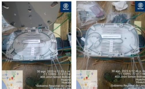
4. SC-00176968 MUFA 2 - SE INSTALO 2 SPLITERS PRINCIPALES HILOS 24-23
