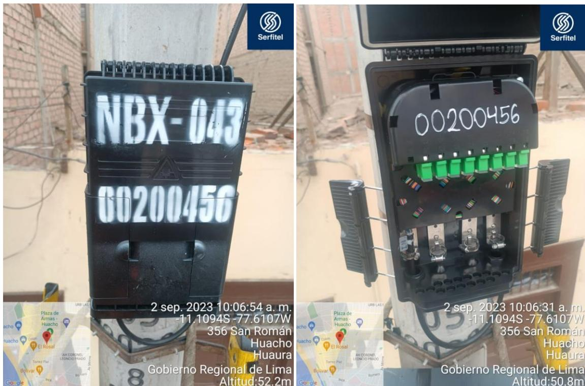
Figura 52. Rotulación e instalación final de caja FAT con divisor óptico de 1x16
