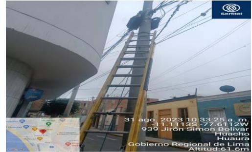
SE INSTALO SC-00176968 MUFA 2 - SE INSTALO 2 SPLITERS PRINCIPALES HILOS 24-23
