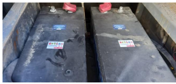
Inspección de baterías
