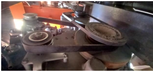
Inspección de fajas / rodajes
