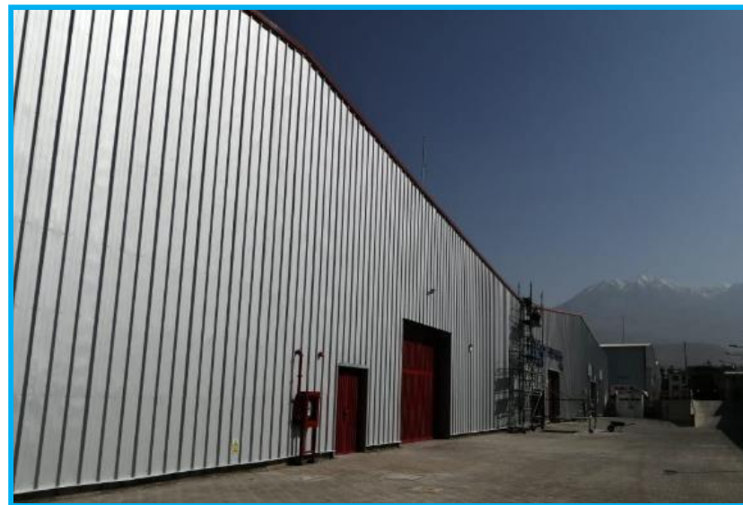
Figura 8. Naves Industriales existentes.
