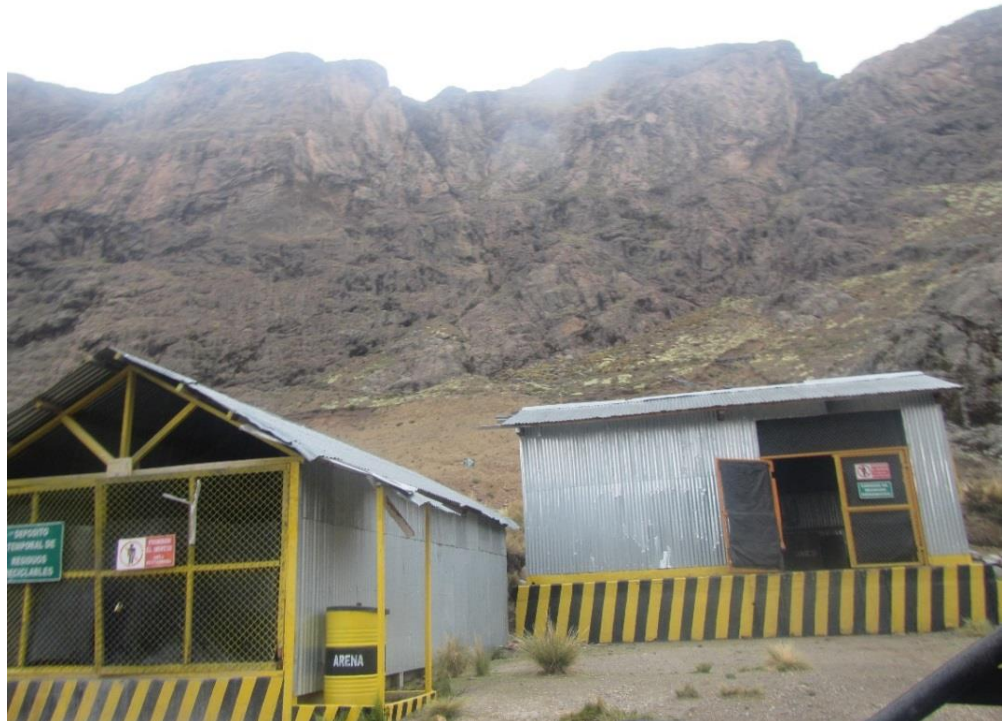
Figura 4. Depósitos temporales de residuos
