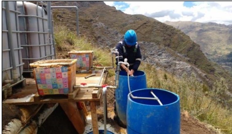
Figura 40: Incorporación de sustratos a humedales aerobios.
