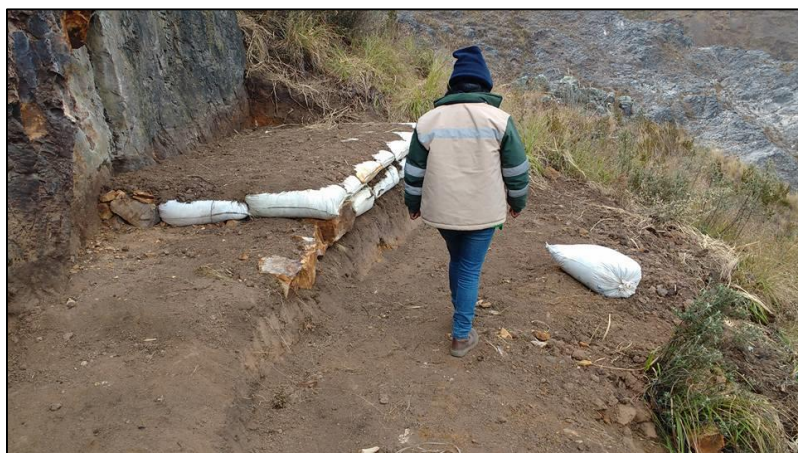
Figura 34: Nivelación del terreno.
