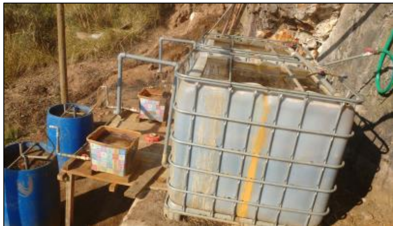
Figura 41: Sustrato incorporados e instalación de tubería para aireación.
