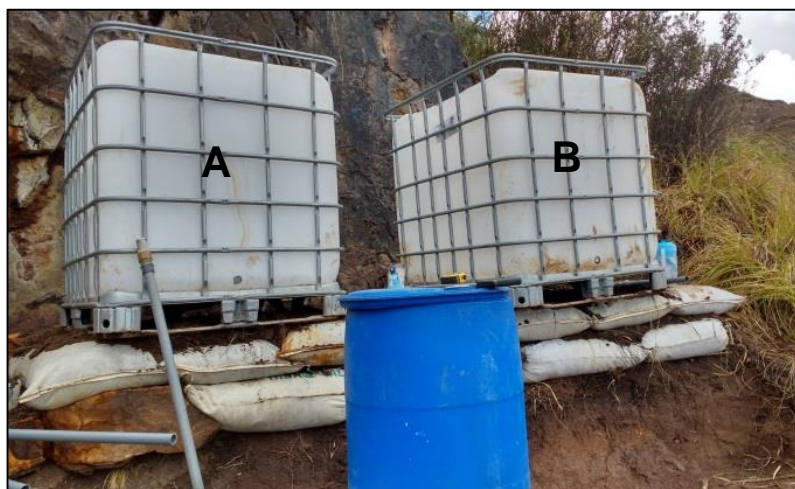
Figura 35: Instalación de los sistemas SAPS y Humedales Aerobios.
