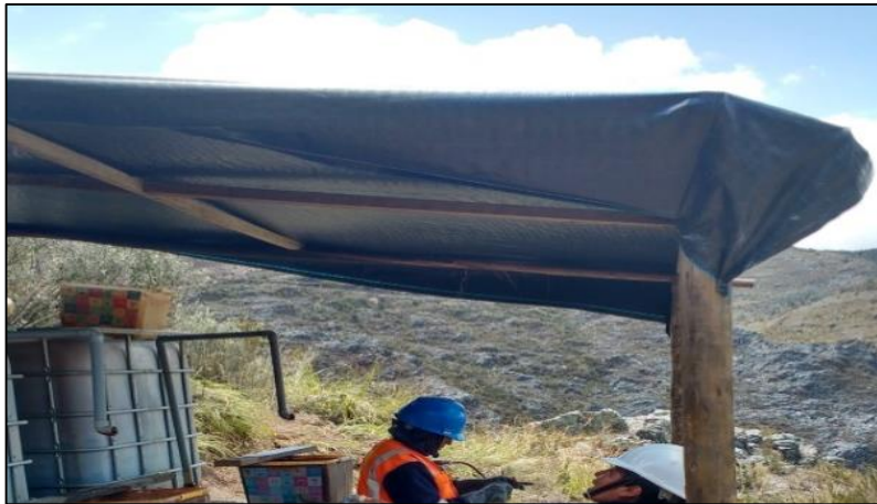
Figura 42: a) Instalación de soporte, b) Instalación de manta arpillera.
