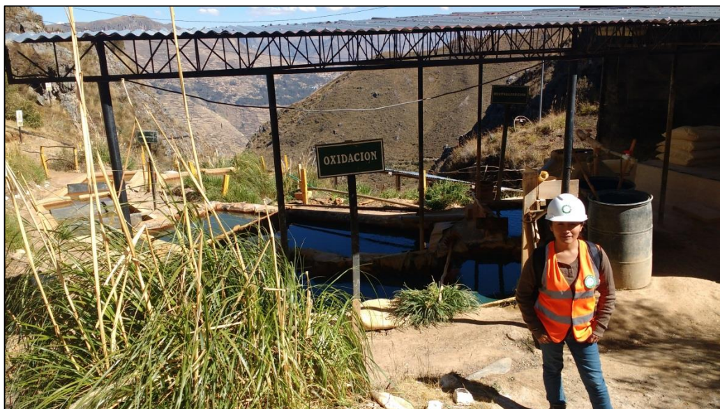
Foto N°2: Planta artesanal de tratamiento químicos de aguas acidas-Azalia.
