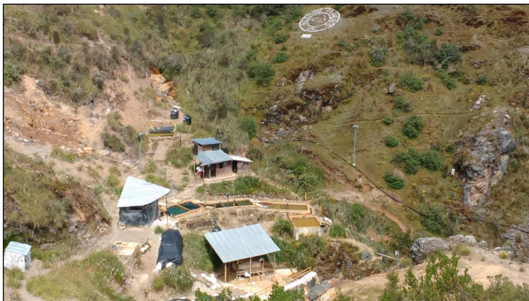
Foto N°1: Circuito de tratamiento de la planta Azalia
