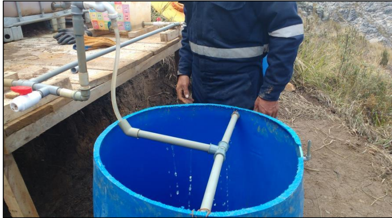
Figura 36: a) prueba hidráulica a los sistemas SAPS, b) prueba hidráulica a los humedales aerobios.
