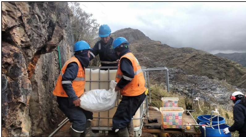
Figura 37: Incorporación de piedra caliza.
