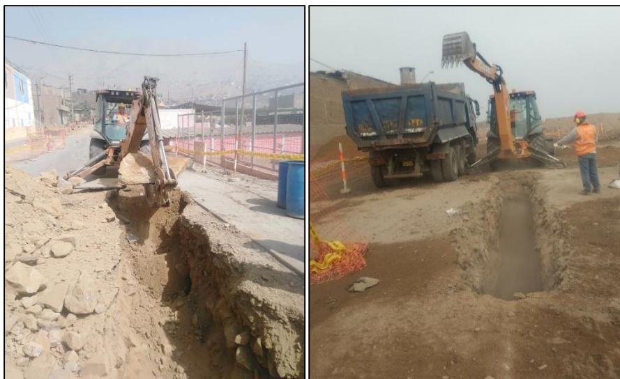
Figura 9: Excavación mecánica en zanjas. Excavación sector 1600 – Malla 1/6 – Huaycán. Elaboración propia.
