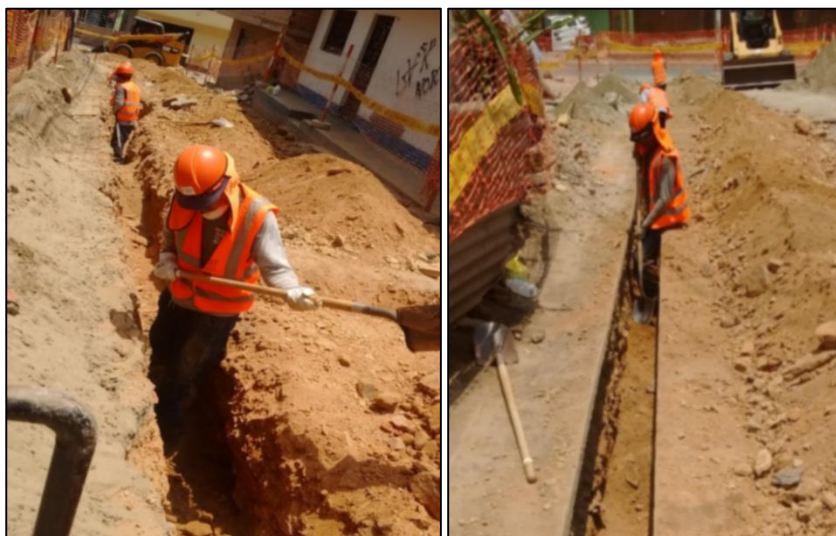
Figura 8: Excavación manual en zanjas. Excavación sector 1380 – Malla 2 – Chosica. Elaboración propia.
