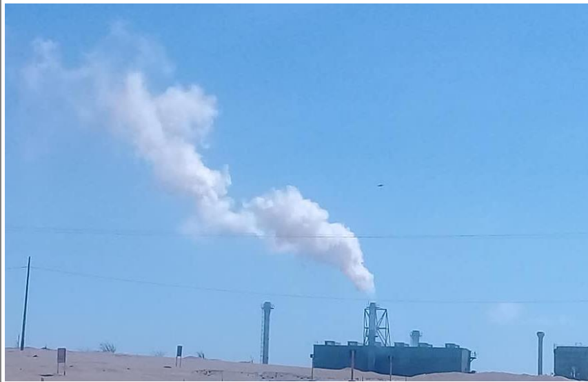
FOTO 03. CHIMENEA FUNDICION EN FUNCIONAMIENTO – VISTA DESDE LA CARRETERA A 5 KM DE PLANTA
