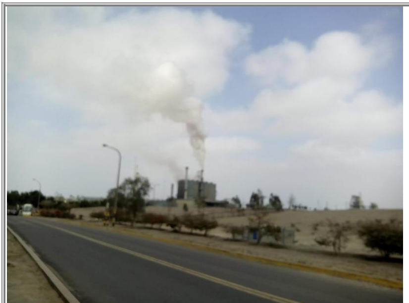
FOTO 02. CHIMENEA FUNDICION EN FUNCIONAMIENTO – VISTA ENTRADA PRINCIPAL A PLANTA
