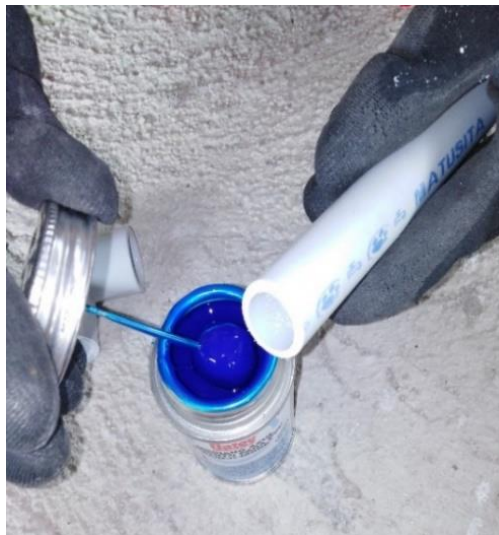
Figura 8. Pegamento azul para conexión de todas las tuberías
