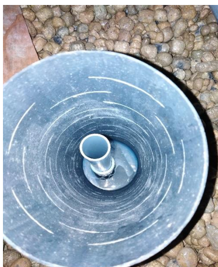
Figura 12. Vista superior del drenaje de agua en la cama de cultivo
