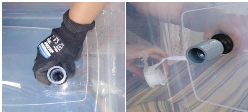
Figura 10. Instalación del niple corrido de 3/4' de diámetro asegurando con teflón.
