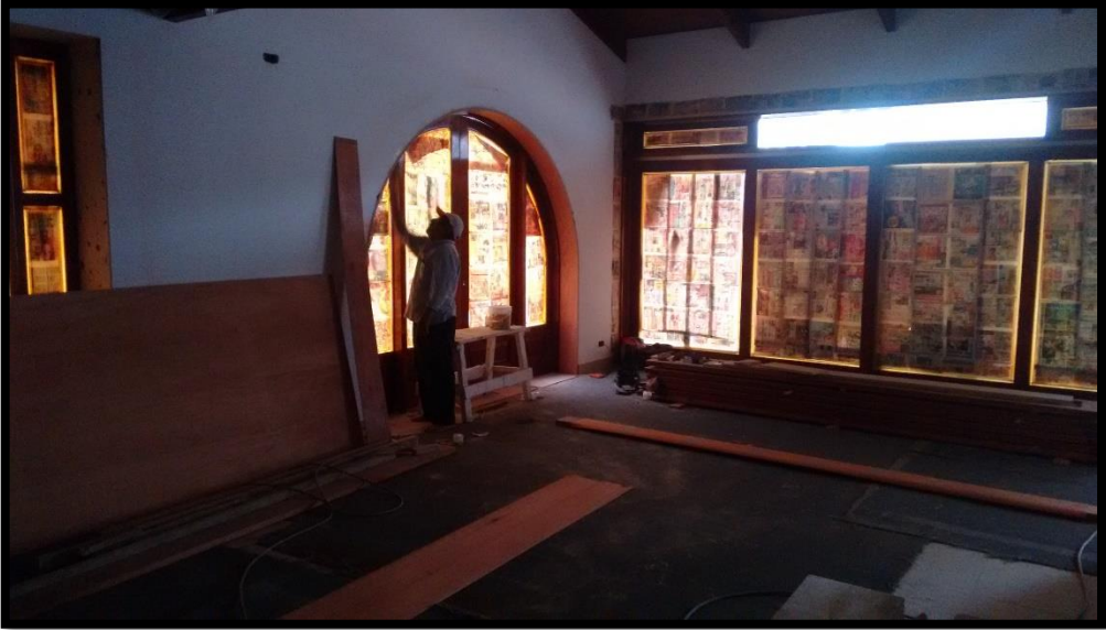
Anexo 8: Trabajos en ambientes con poca ventilación e iluminación
