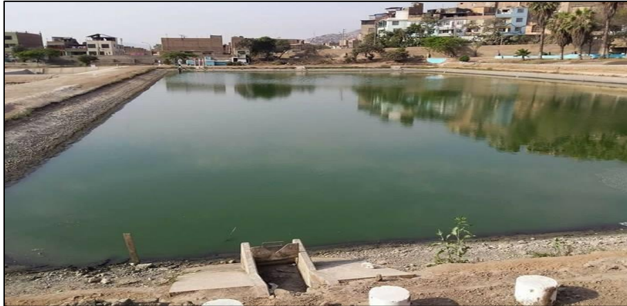
Figura 6. Laguna facultativa secundaria. Fuente: Elaboración Propia.
