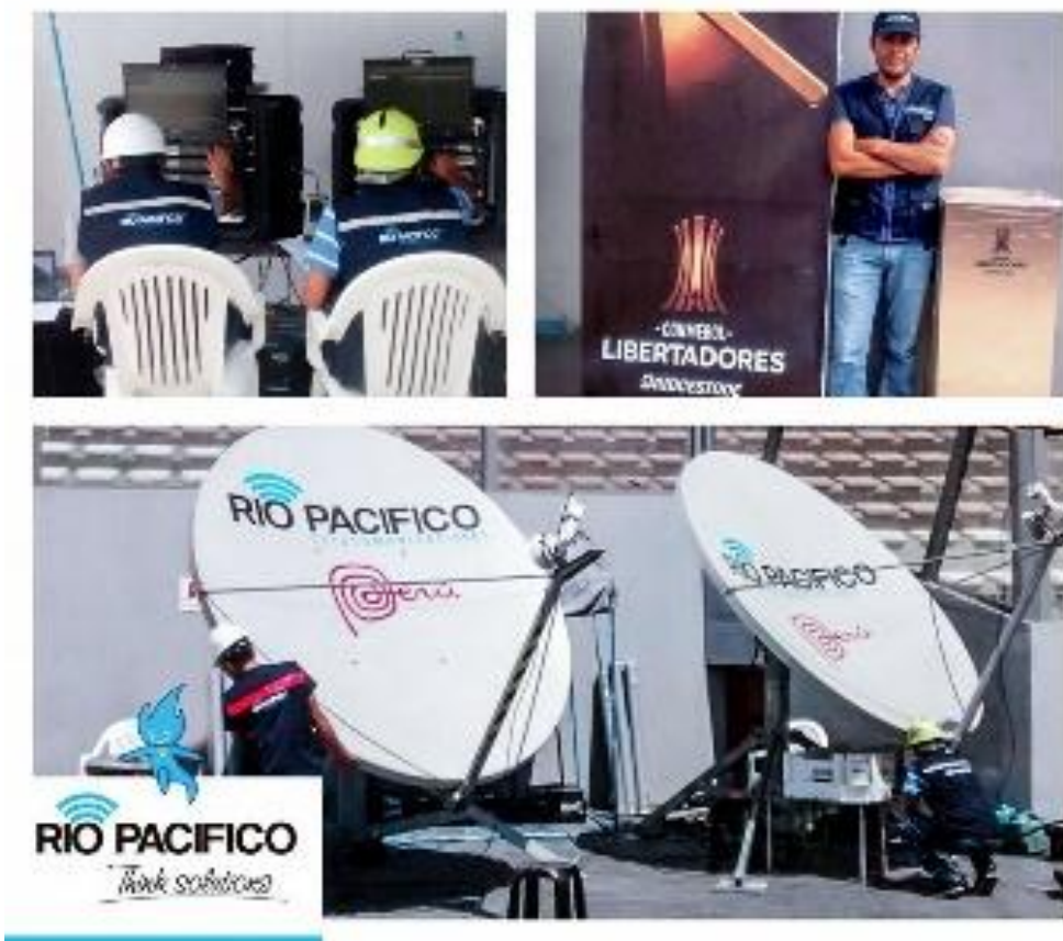
Figura 11 Equipos de transmisión de televisión
