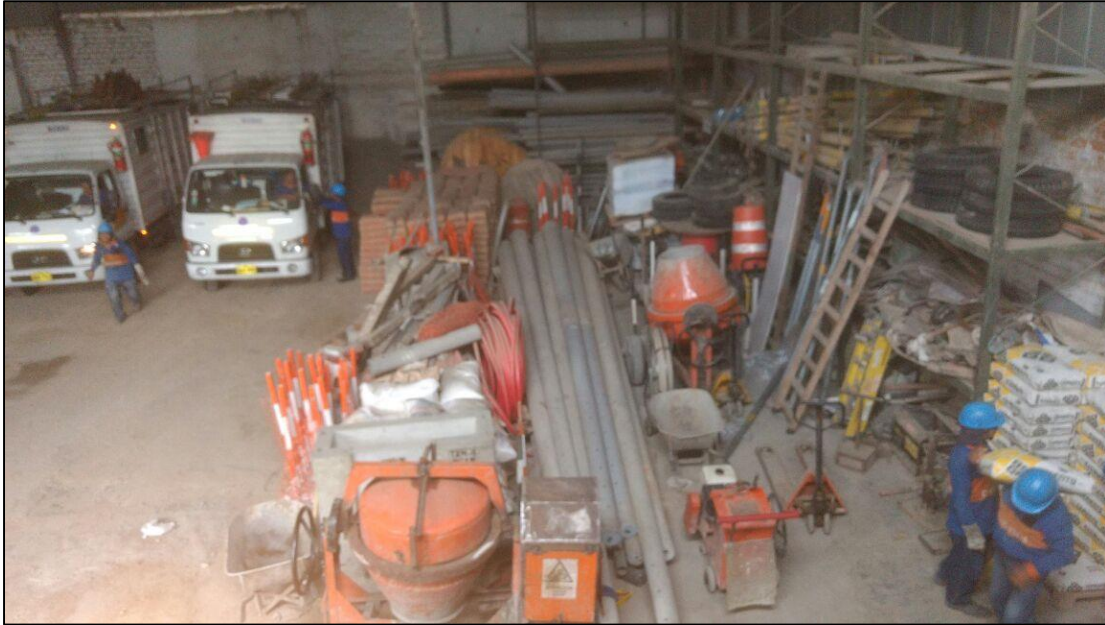
Figura 30: Empresa LO SA VIAL SAC –Almacén de Agregados
