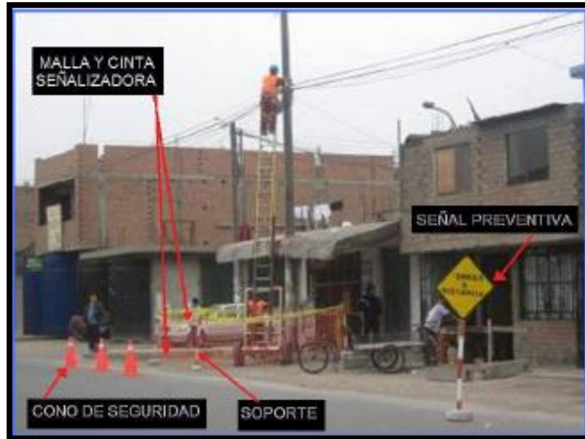
Figura 37. Seguridad en la zona de trabajo.
