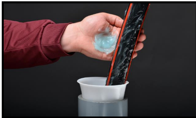
Figura 41. Proceso de lubricación de cables de fibra óptica.
