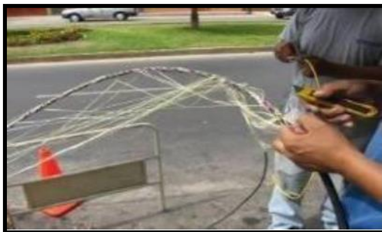
Figura 48. Retiro de protección de la fibra.
