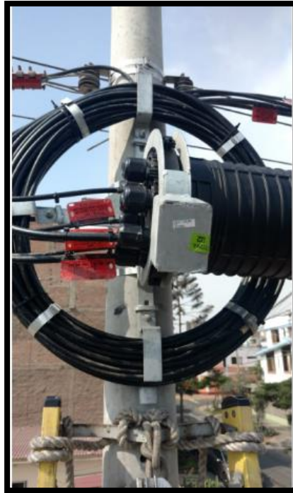
Figura 58. Acondicionamiento de mufa para entrega.
