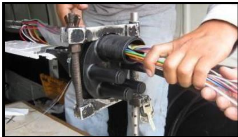
Figura 50. Acondicionamiento de la fibra en mufa.
