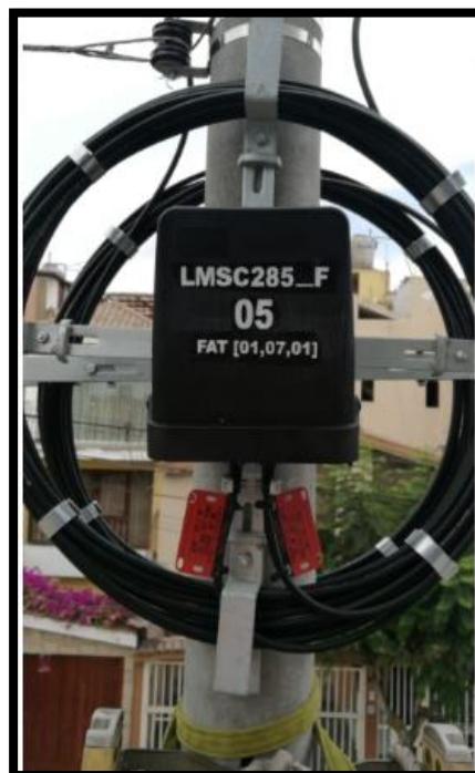
Figura 59. Acondicionamiento de equipo FAT para entrega.
