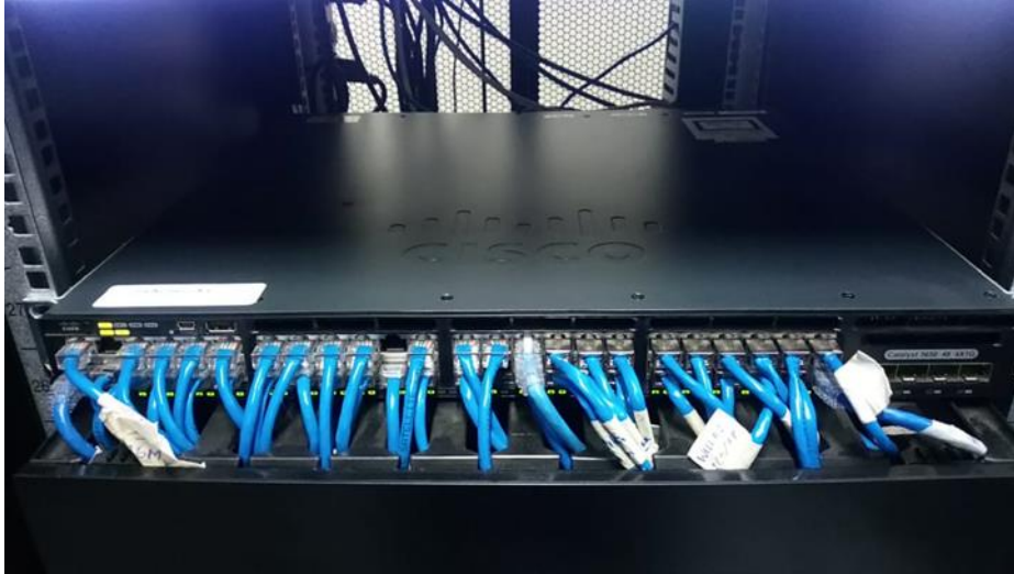
Figura 26 Switch Cisco de procesamiento de TS.
