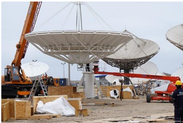
Figura 31 Antena en banda Ku a utilizar para la transmisión.
