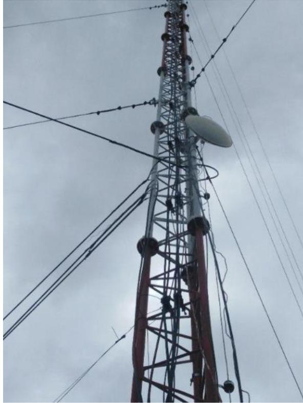
*Figura 25.* Torre tipo ventada
