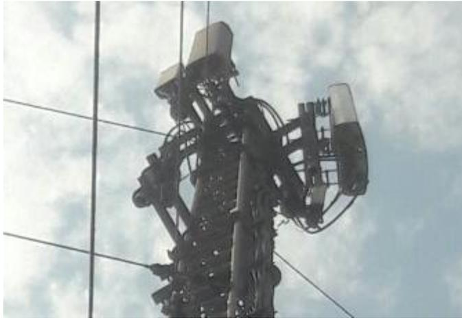
*Figura 4.* Antenas tipo Sectoriales ubicadas en una torre
