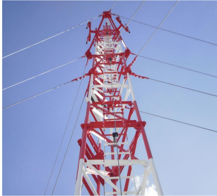
Figura 8 : Tipo Arriostradas o atirantadas Fuente: Elaboración propia
