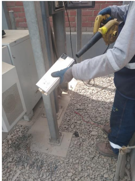
Figura 32: Limpieza de rectificador Fuente: Elaboración propia
