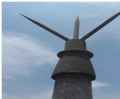
Figura 22: Pararrayos. Fuente: Elaboración propia
