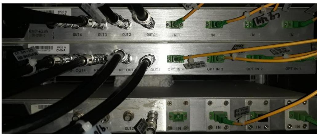
Figura N° 14: Receptores ópticos (Posterior)
