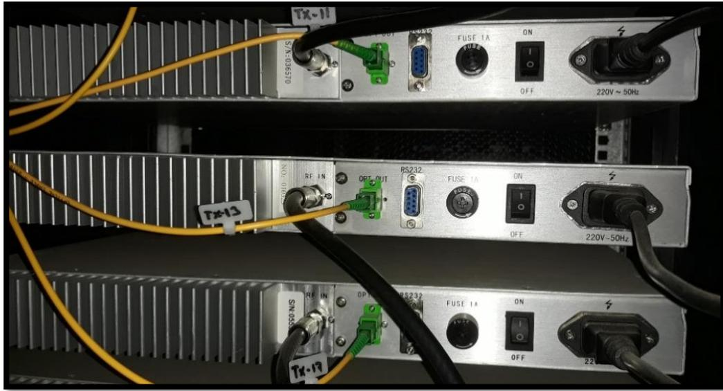
Figura N° 11: Transmisores ópticos (Posterior)
