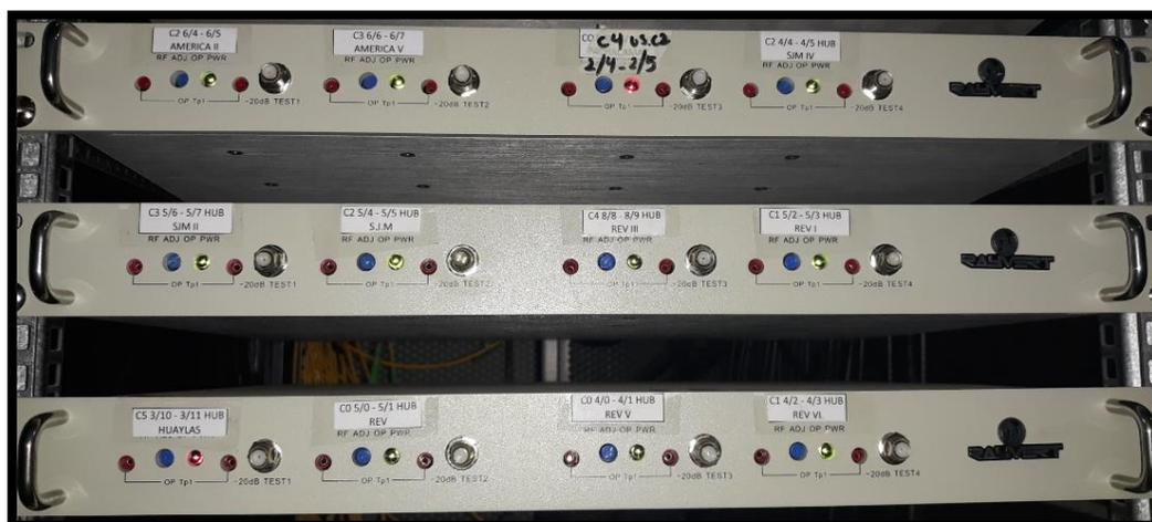
Figura N° 13: Receptores ópticos (Frontal)
