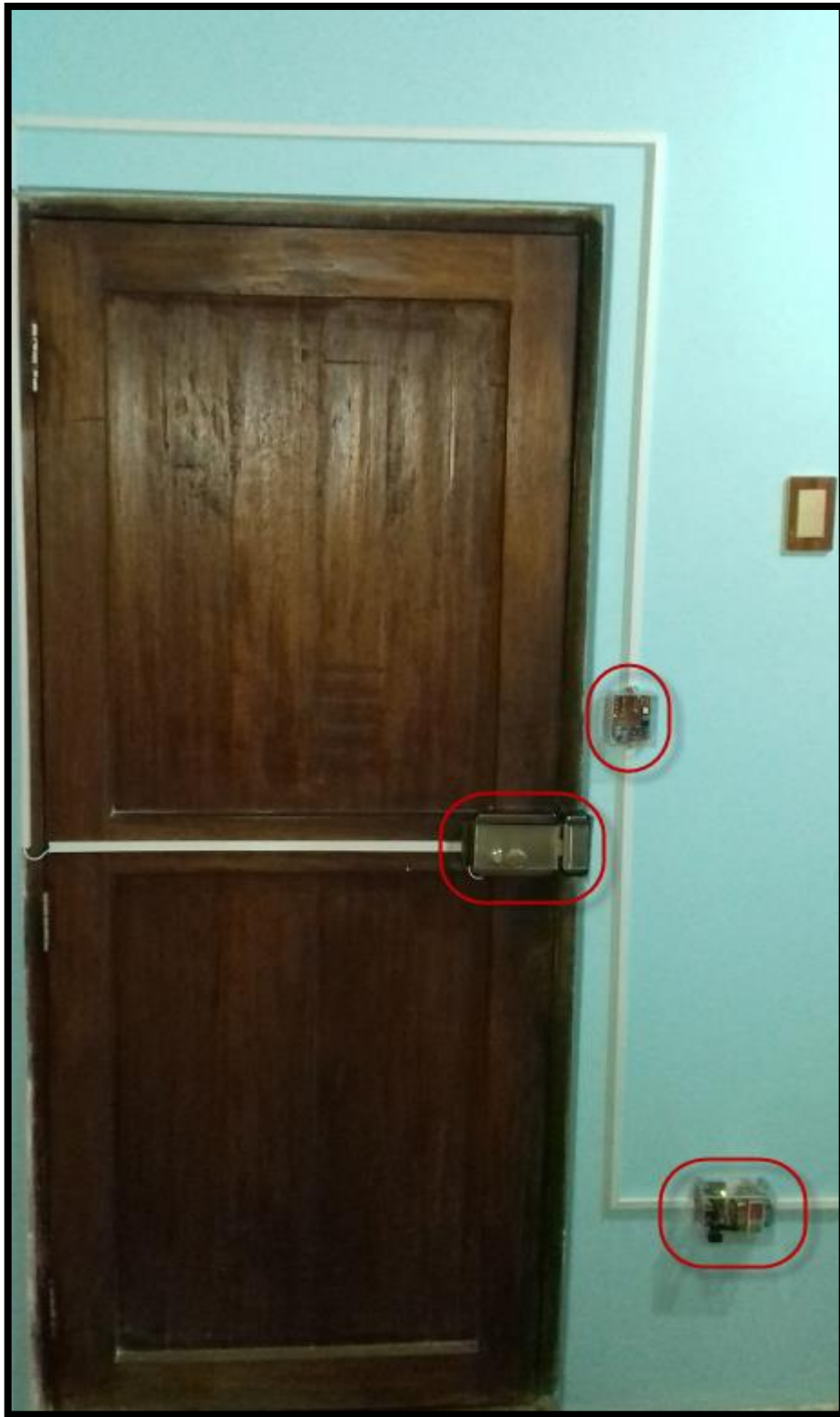
Figura 82: Instalación del Dispositivo de control de acceso 2,3 y cerradura
