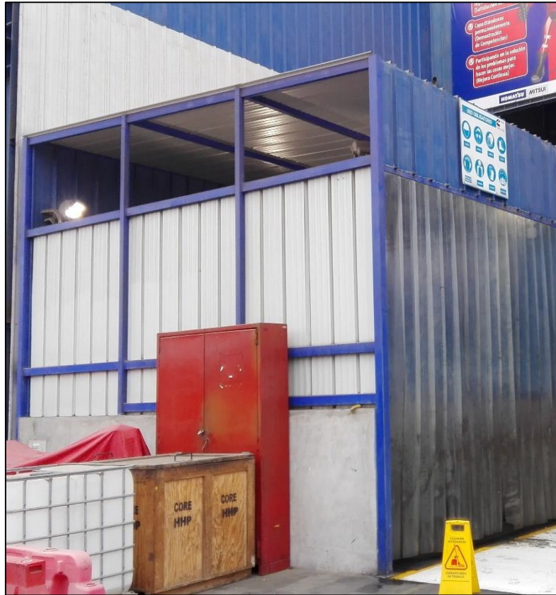
Figura 14: Zona de Lavado de la planta Komatsu - I Fuente: Tomado de las instalaciones de la planta Komatsu ubicado en la Av. Argentina N° 4453 – Callao
