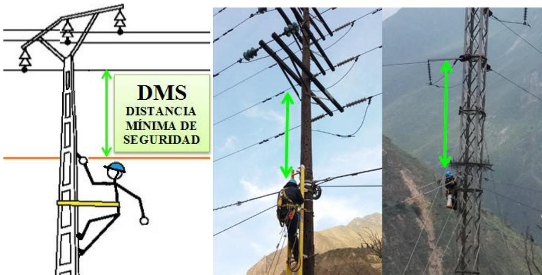
Figura 24. Distancia mínima de seguridad para personal técnico.
