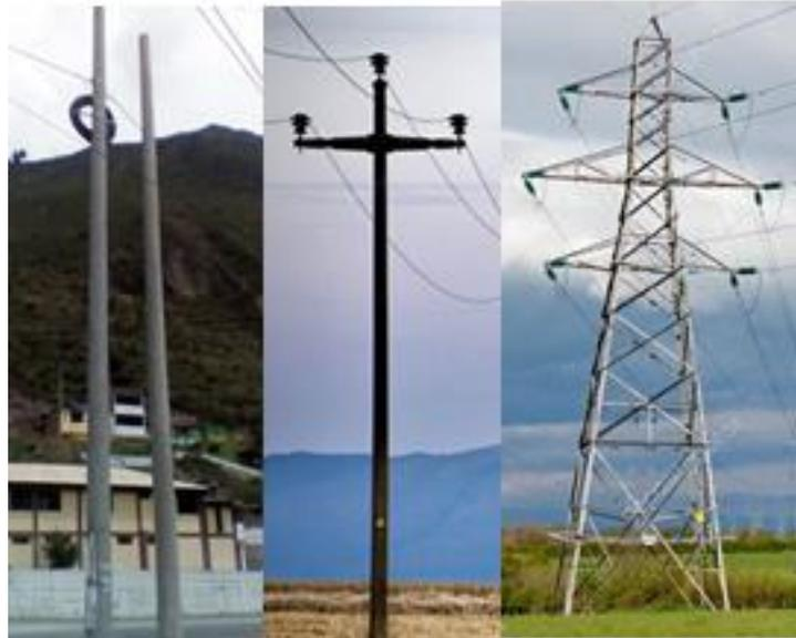
*Figura 15.* Postes y torres, utilizados en tendido aéreo de fibra óptica
