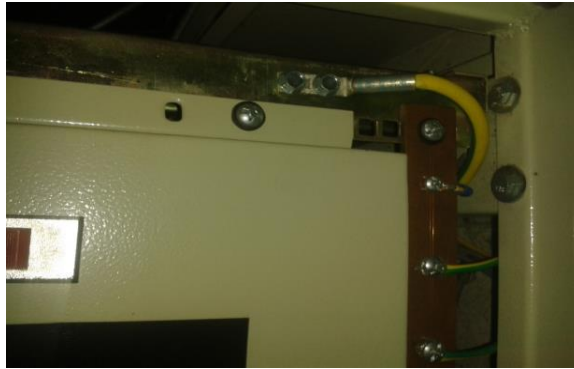
Figura 9. Conexión de puesta a tierra Elaboración propia
