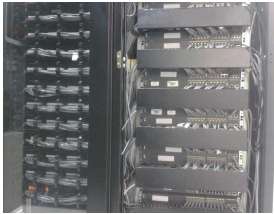
Figura 40. Gabinetes para el servicio datos Elaboración propia
