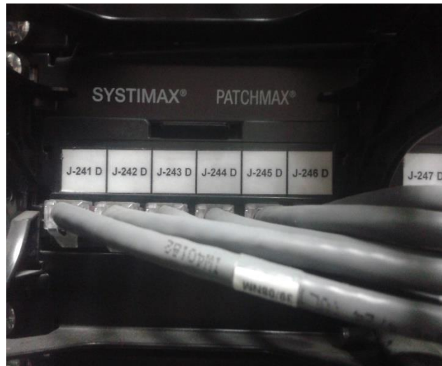
Figura 8. Etiquetado en el panel de puertos Elaboración propia
