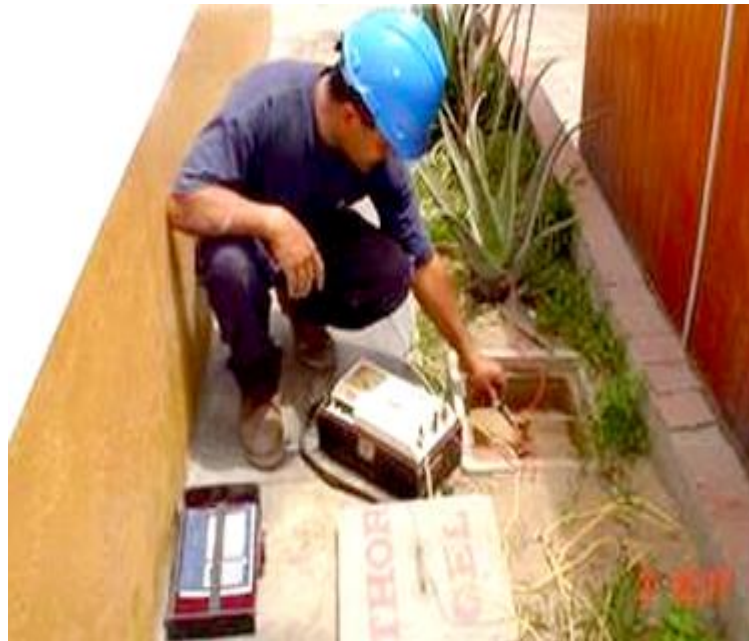
Figura 31. Pozo asignado para el cable óptico Elaboración propia
