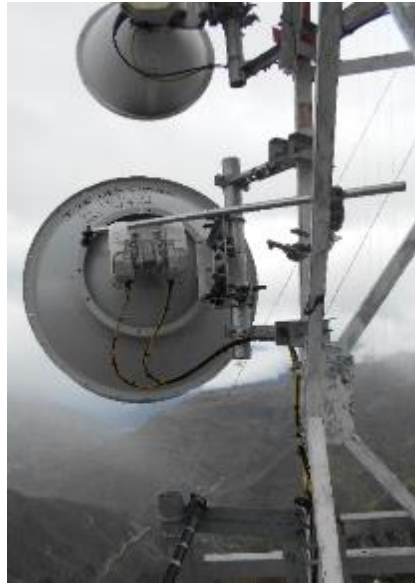
Figura 31 - Instalacion de nueva Antena, ODUs, Acoplador instalado y cableado.
