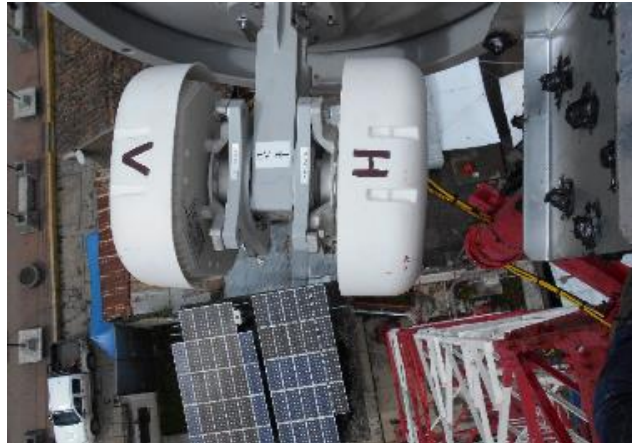
Figura 24 - Radio Horizontal y Radio Vertical Acoplados Al Híbrido.
