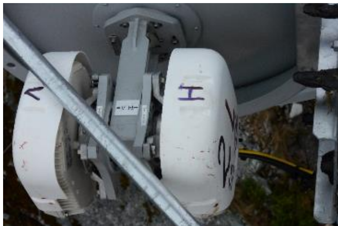
Figura 33 - Radio Horizontal Y Radio Vertical Acoplados Al Híbrido.
