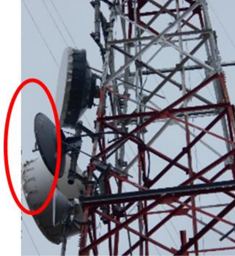
Figura 29 - Antena existente antes de ser reemplazado.
