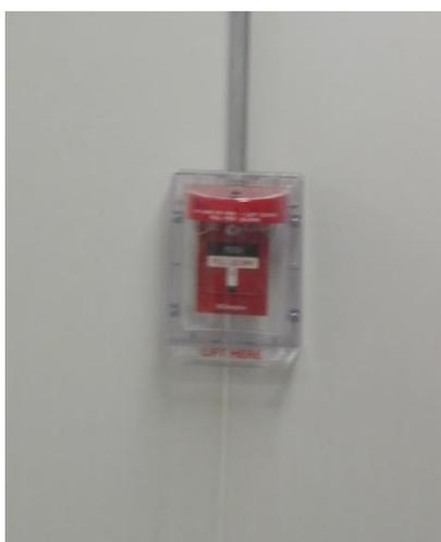
Figura 3.7: Estación manual con Stopper
