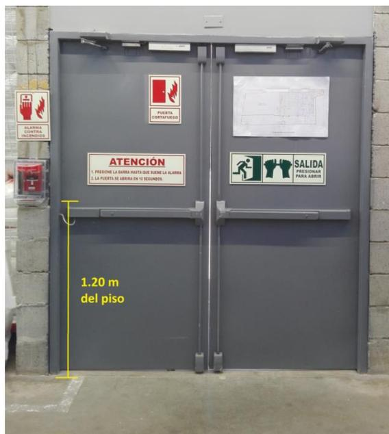
Figura 3.6: Ubicación de la estación manual según NFPA
