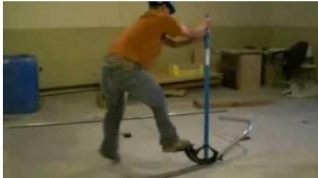
Figura 3.3: Doblado de tubos Conduit EMT
