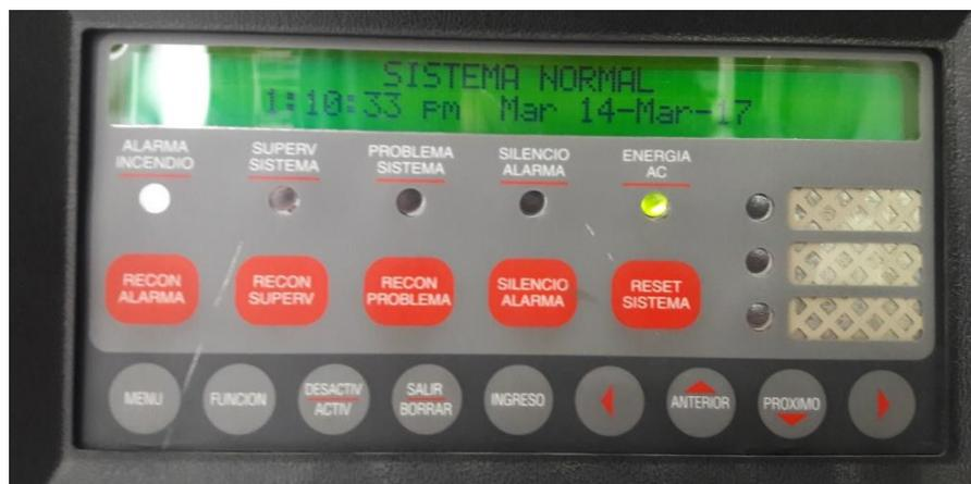
Figura 3.17: Prueba del panel de alarmas
