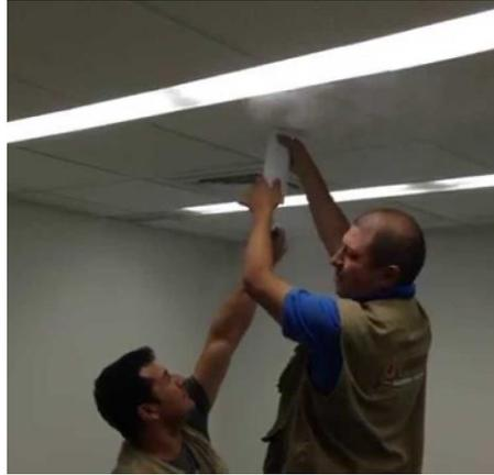
Figura 3.13: Prueba de funcionamiento del detector de humo
