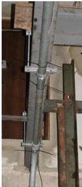
Figura 3.14: Resultado del canalizado de tubos Conduit EMT
