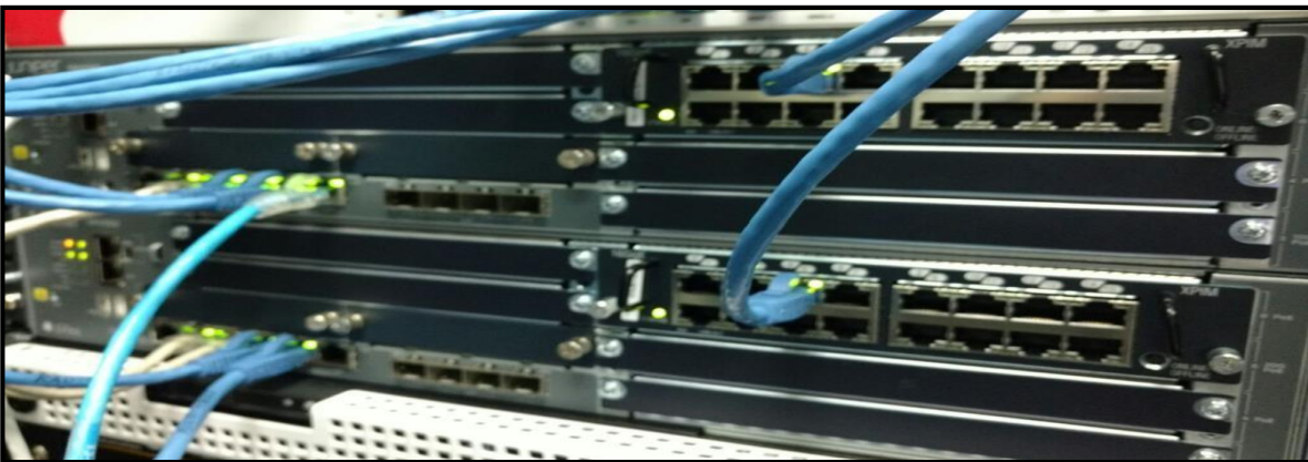
Figura 3.12: Firewall Juniper SRX550 Fuente: Elaboracion propia
