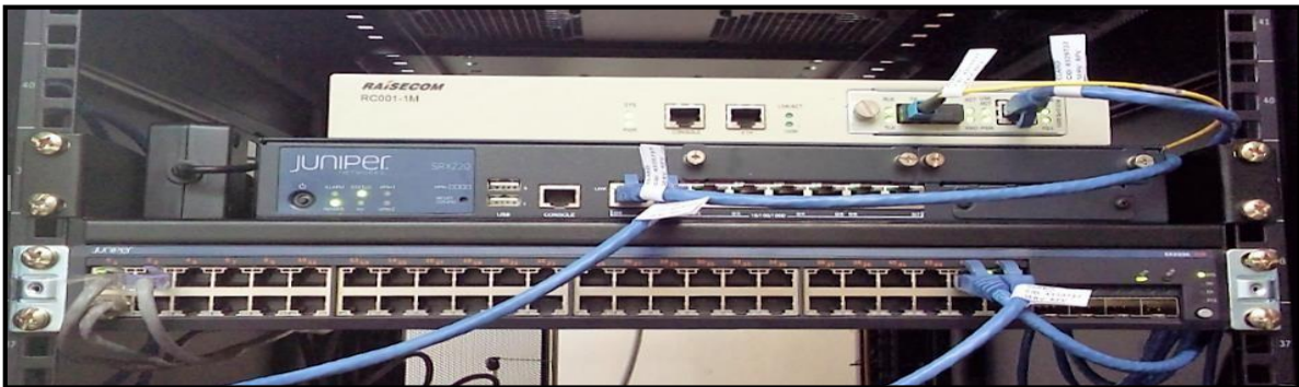
Figura 3.14: RPV con SRX220 en sedes remotas Fuente: Elaboracion propia
