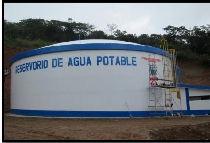
Figura 32. Reservorio de agua potable.
