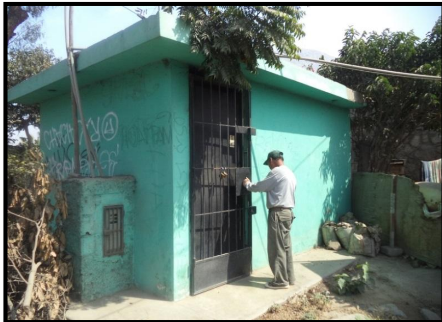
Figura 35. Caseta de bombeo del pozo subterráneo.
