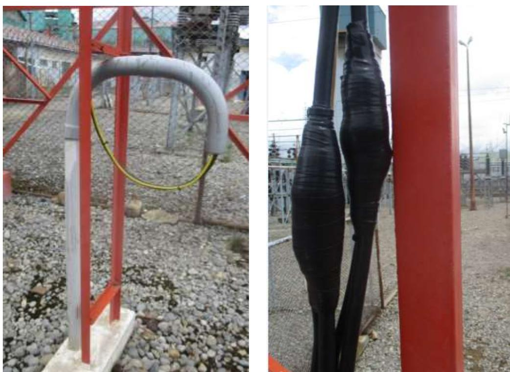
Figura 3. 19: Sellado de tubo de ingreso y peinado de cableado vertical
