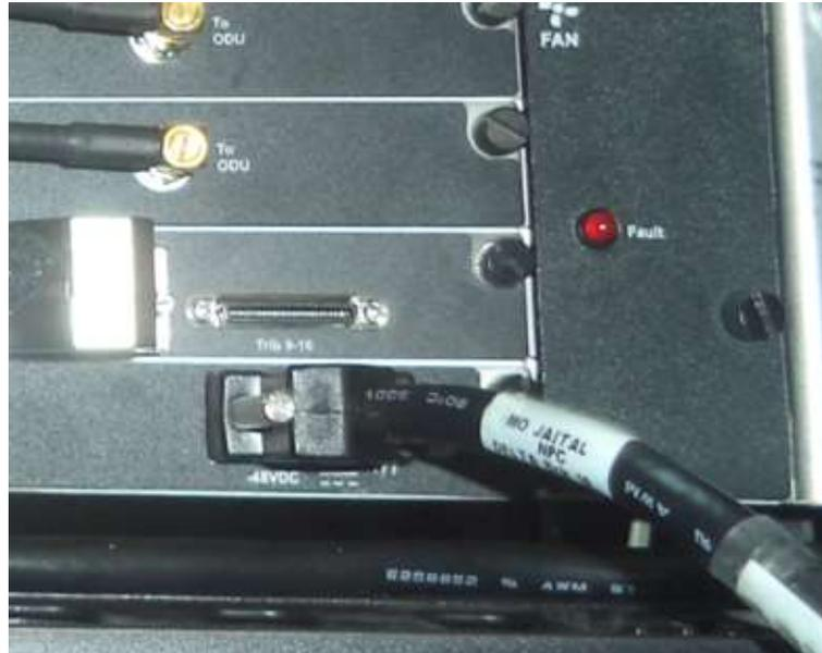
Figura 3. 14: Cable de energía para NCC
