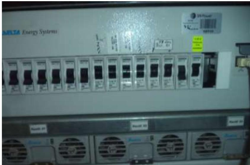
Figura 3. 12: Distribuidor DC 48 V, Ubicado en el gabinete de comunicaciones
