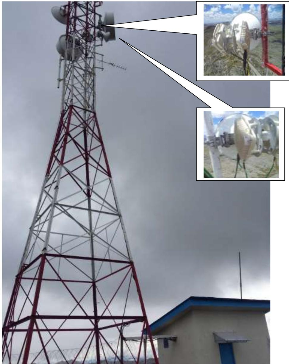
Figura 3.17: Instalación de la antena y ODU en torre de comunicaciones
