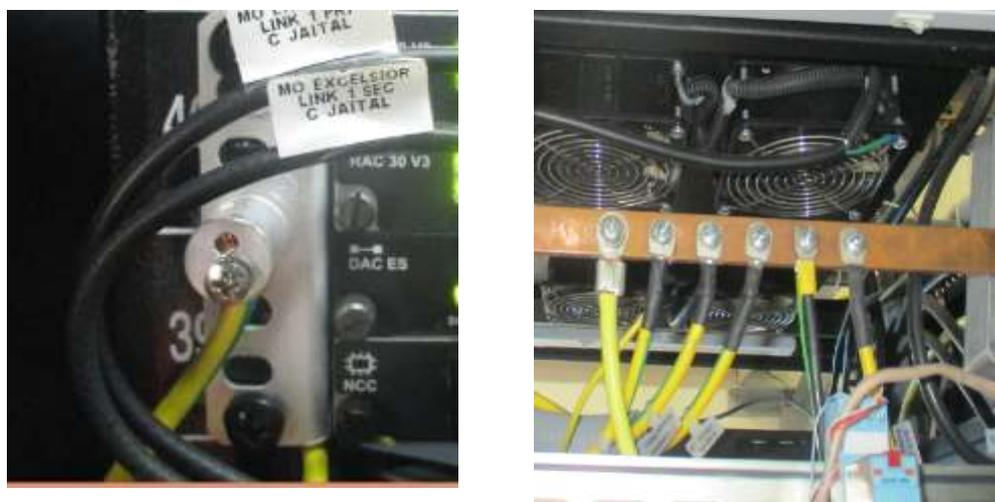
Figura 3. 15: Aterramiento de la radio Aviat
