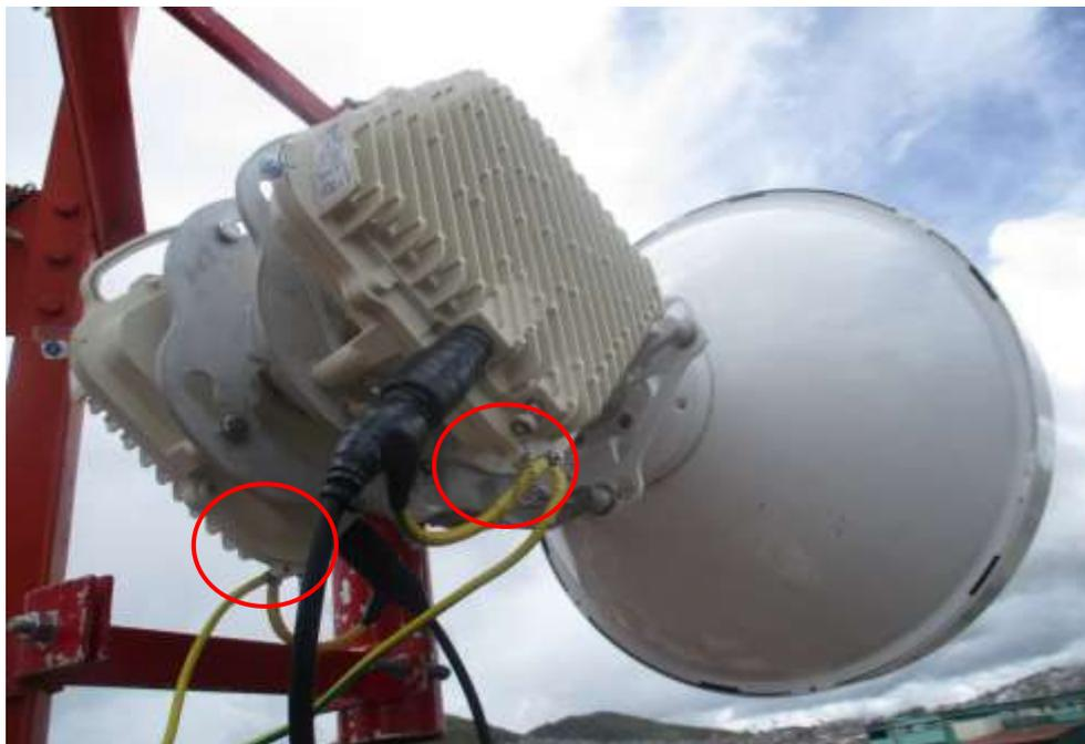
Figura 3. 16: Aterramiento de la ODU instalado en la torre
