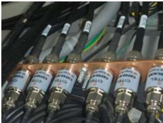
Figura 3. 11: Etiquetado de los lightning arrester
