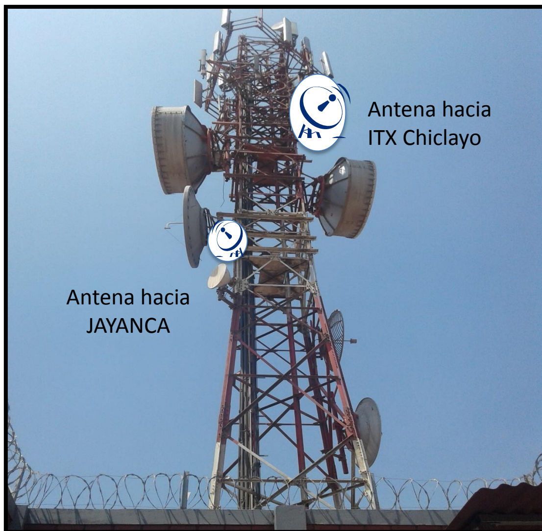
Figura 3.15. Torre Autosoportada en ATC Sapame.
