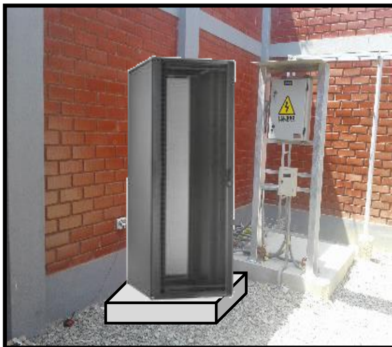
Figura 3.16. Ubicación del nuevo gabinete y tablero de energía.
