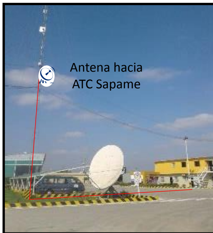
Figura 3.19. Torre ventada en JAYANCA.
