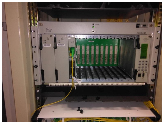
Figura 38: Amplificador EDFA en Hub Chorrillos
