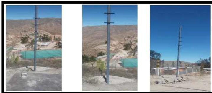
Figura 3.12. Postes instalados para tendido de cable RG8
