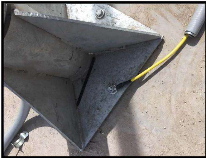
Figura 3.17. Anclaje y aterramiento del mástil en la planta minera.
