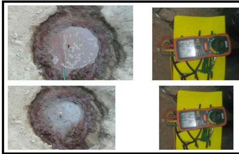
Figura 3.13. Pozos a Tierra instalados tanto para la planta minera, como para el data center
