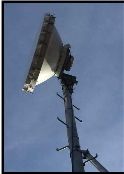
Figura 3.27. Antena y ODU, se aprecia el cableado coaxial RG8 y el aterramiento en la Planta Minera
