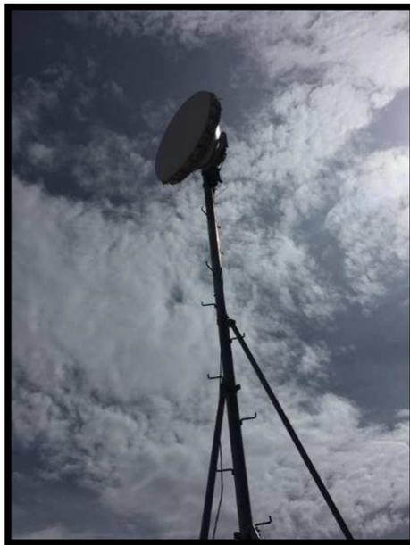
Figura 3.20. Antena y ODU instalada en Mástil en la Planta Minera
