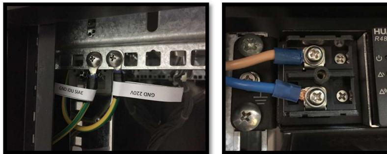
Figura 3.23. Aterrado de IDU y Conectorizado en Conversor -48VDC en Data Center de la Planta Minera
