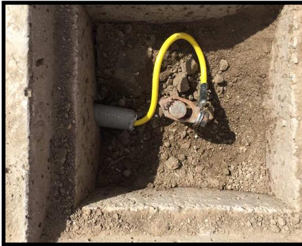
Figura 3.18. Aterramiento del mástil en el pozo a tierra
