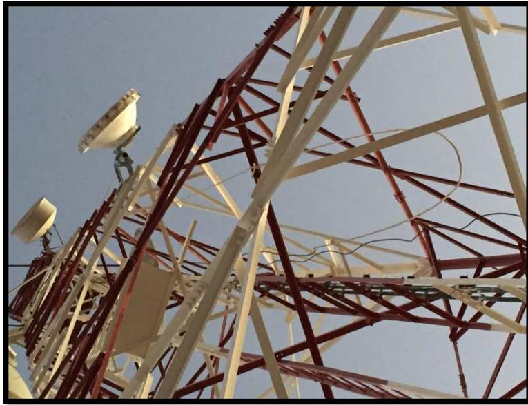
Figura 3.21. Instalación de Antena y ODU en torre autosoportada en la Repetidora
