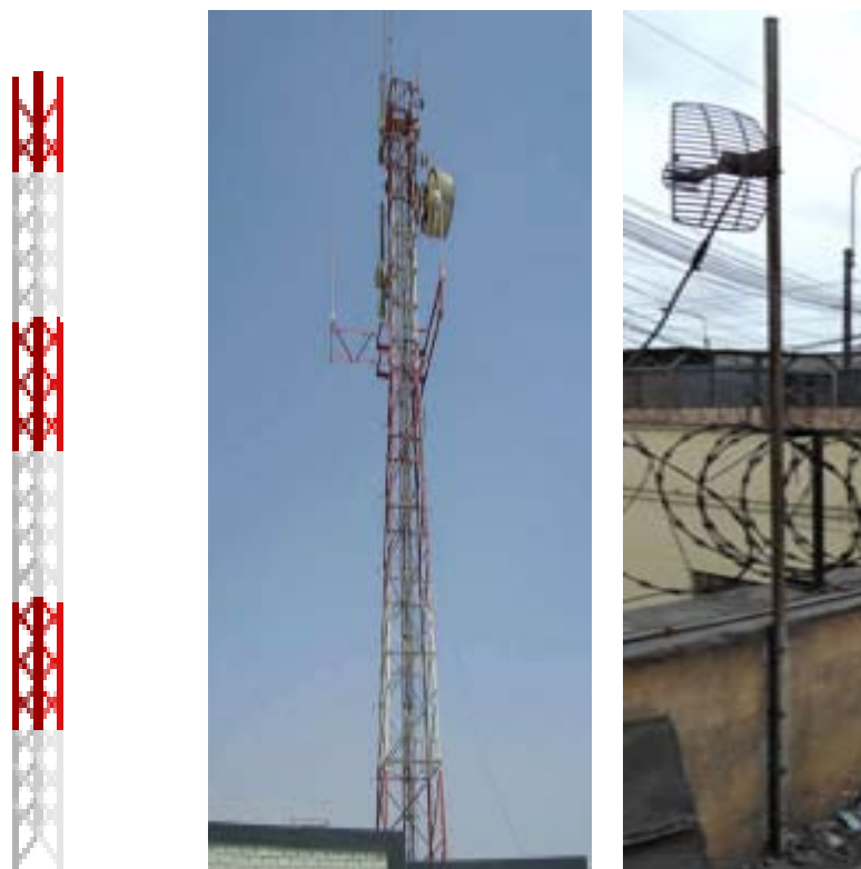
Fig. 2.20. A la izquierda una torre ventada, al centro una torre auto-soportada metálica tipo Z y a la derecha un mástil
