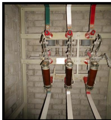
Figura 12: Celda de llegada
