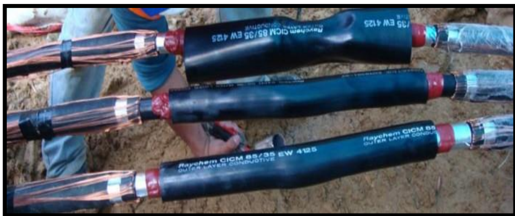
Figura 56: Empalme asimétrico para NKY-NA2XSY EFSJ-17 a /1XU-35B-PE01
