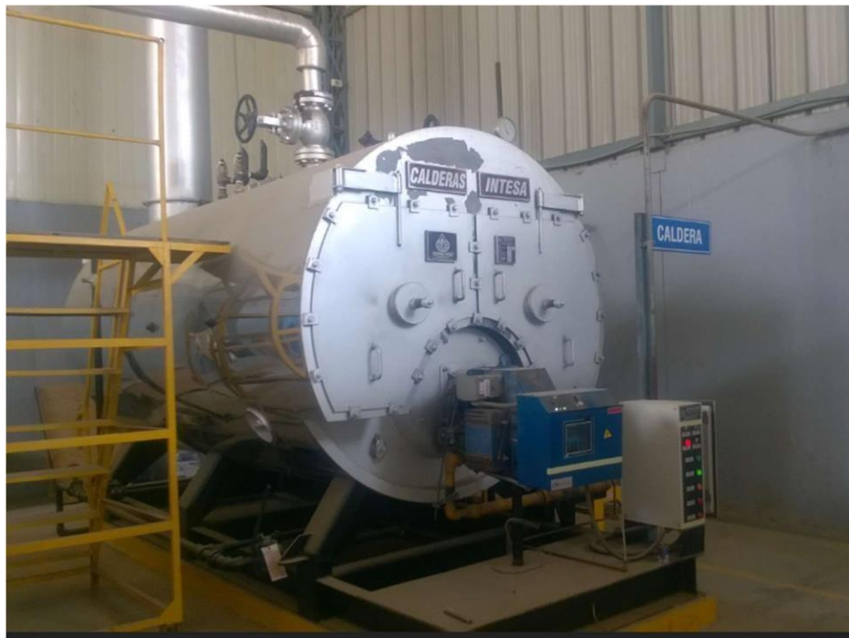
Figura 05. Caldera Piro tubular Horizontal
