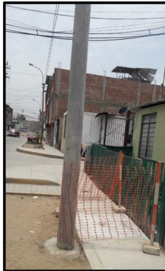
Figura 32: Poste nuevo instalado
