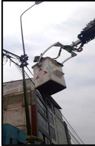
Figura 27: Escalamiento de poste
