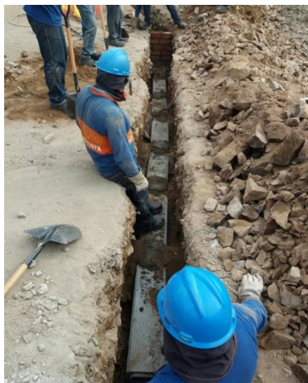
Figura 45. Instalación de ductos 4 vías, para la cruzada
