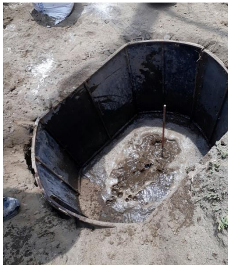
Figura 22. Instalación de puesta a tierra.
