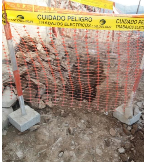
Figura 32. Excavación en zona rocosa
