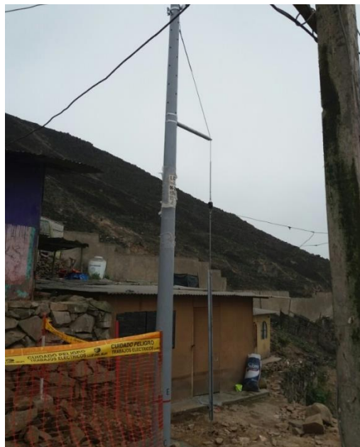
Figura 39. Instalación de retenidas
