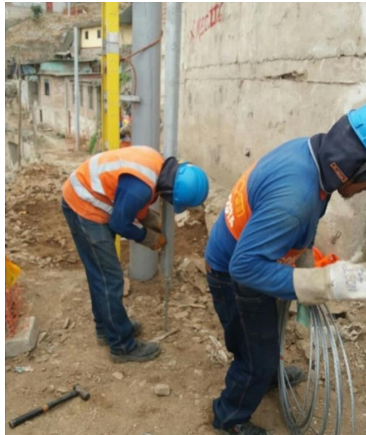
Figura 49. Instalación de retenidas faltantes
