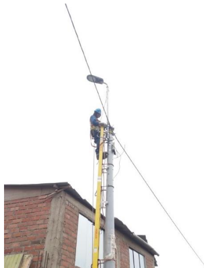
Figura 41. Instalación de pastorales y conexión de vanos.
