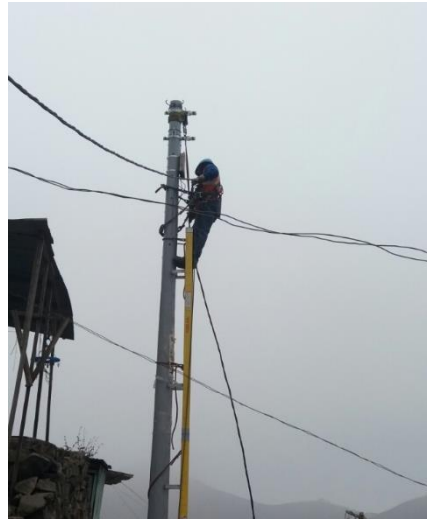
Figura 40. Instalación de ferretería, caja lonchera de distribución
