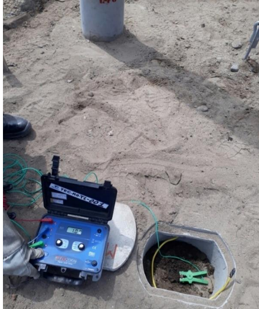
Figura 26. Medición de puestas a tierra.
