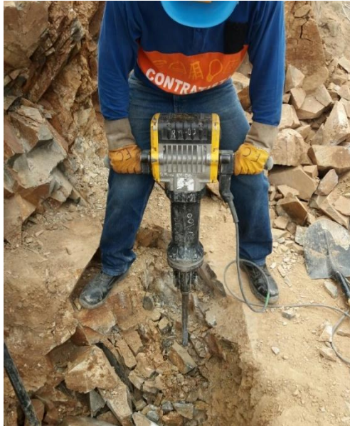
Figura 38. Apertura de hoyos para retenidas.
