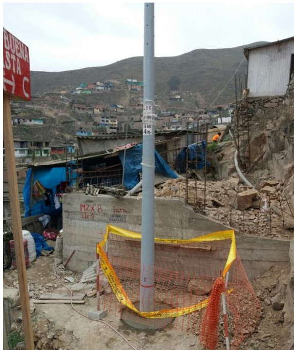
Figura 35. Poste instalado, vista panorámica
