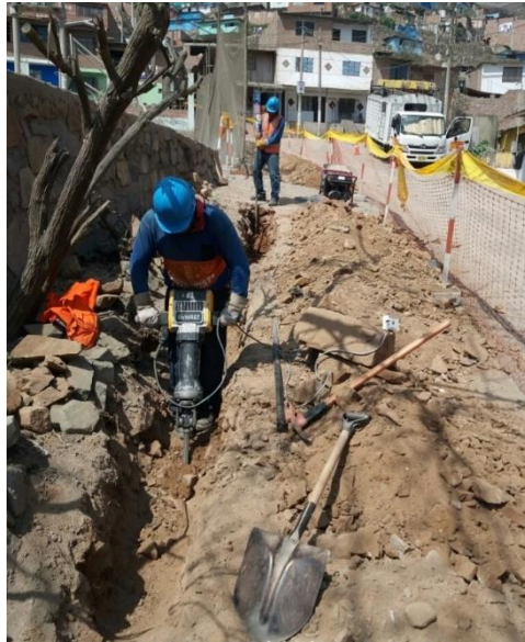
Figura 42. Inicio de apertura de zanja.
