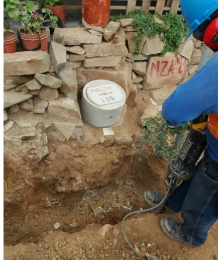
Figura 50. Apertura de hoyos para puesta a tierra.
