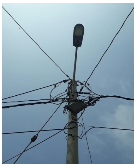
Figura 23. Empalmes y conexiones
