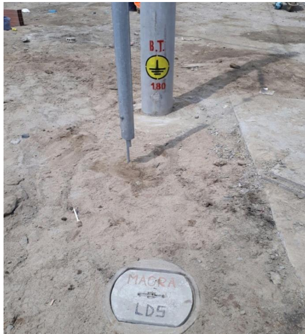
Figura 28. Trabajos de puesta a tierra terminados
