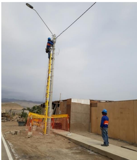
Figura 21. Instalación de ferretería
