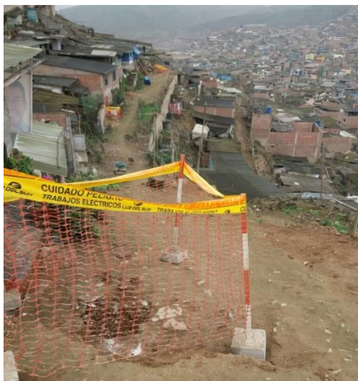
Figura 31. Ejecución de excavación para los postes de fibra
