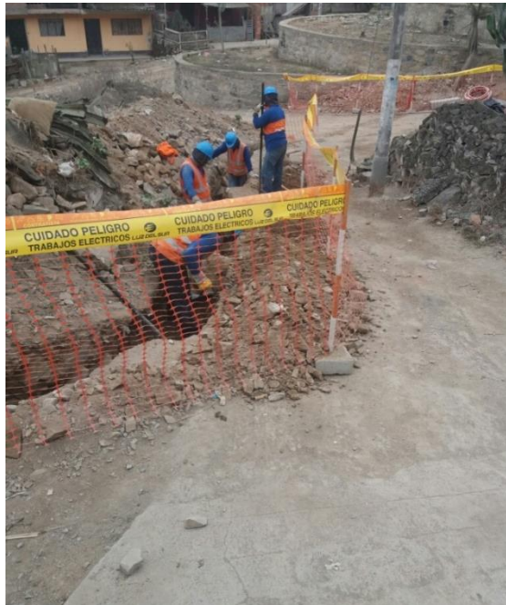
Figura 44. Término de la apertura de zanja y correcta señalización de trabajo.
