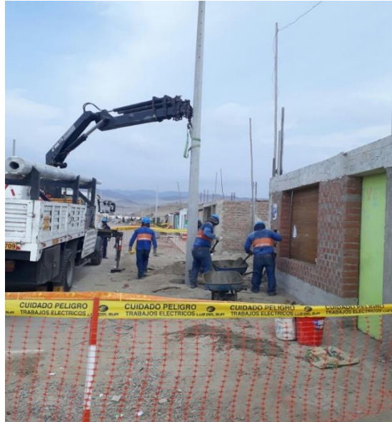
Figura 18. Instalación de poste con apoyo de una grúa hidráulica.
