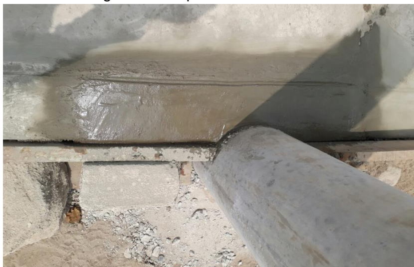
Figura 27. Reparación de veredas.
