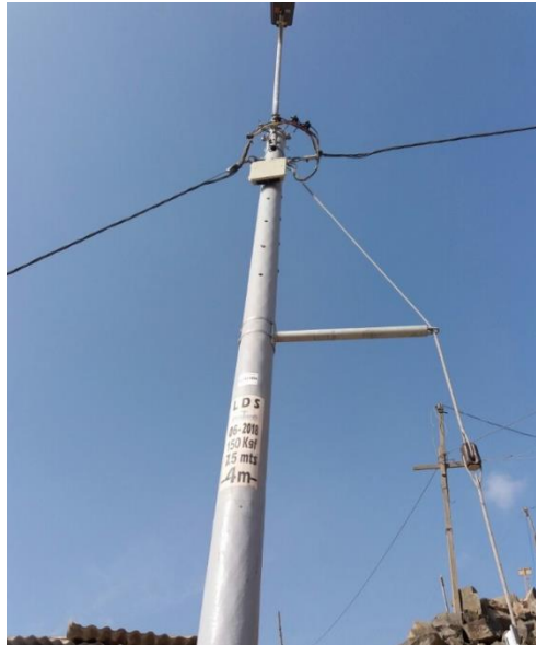
Figura 52. Fin de obra
