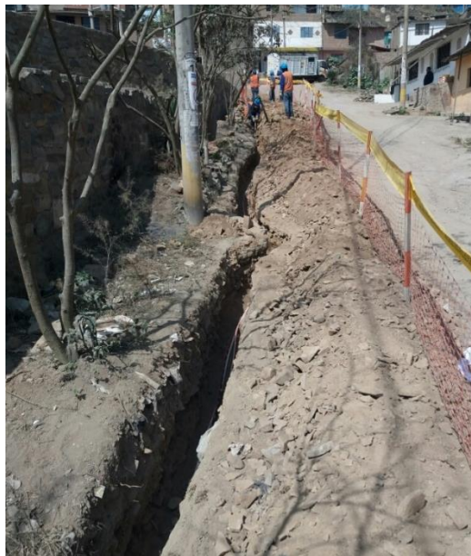
Figura 43. Apertura de zanja
