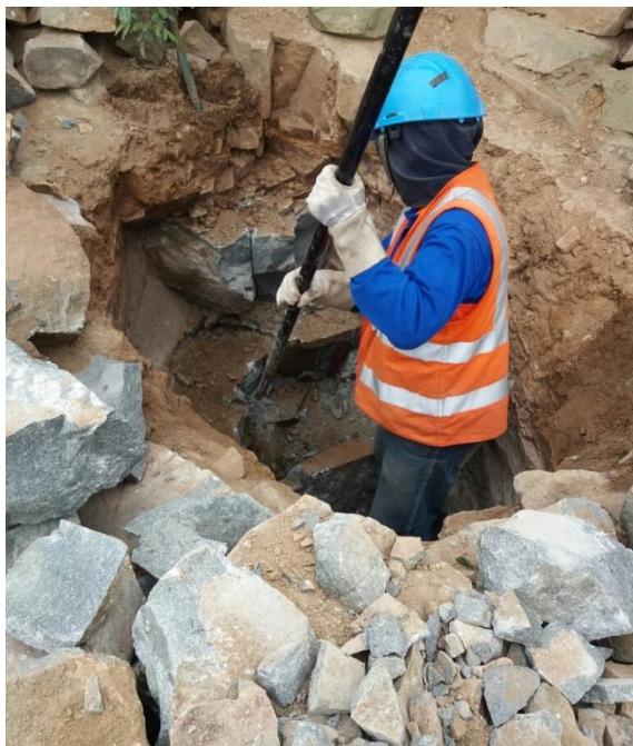
Figura 37. Excavación para retenidas
