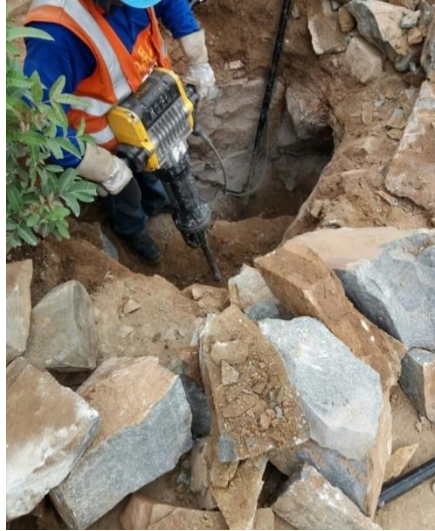
Figura 48. Apertura de hoyos, para retenidas faltantes
