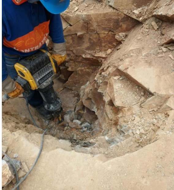
Figura 36. Perforación con uso de rotomartillo.
