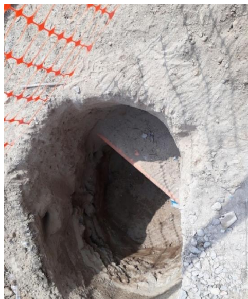
Figura 19. Ejecución de excavación para la instalación de retenidas.
