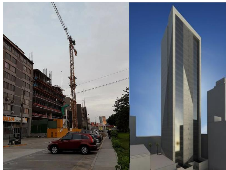
Figura 9 Edificio de Oficina Torre Forum, en construcción y maqueta.
