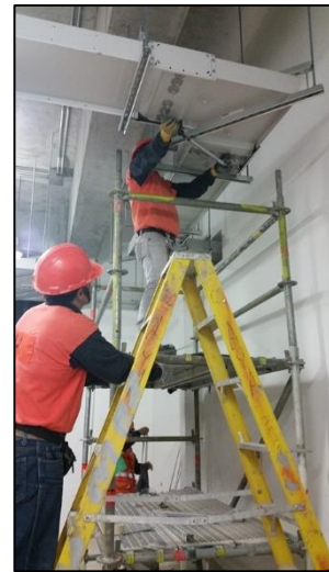
Instalación de soportería
