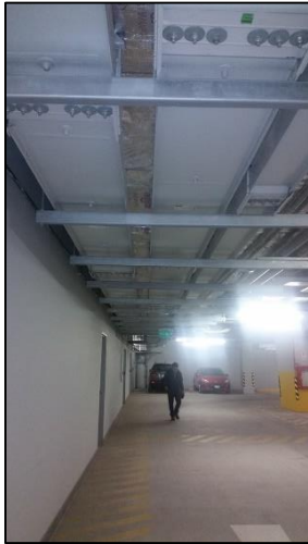
D.B. en trazo horizontal en sótano en paralelo
