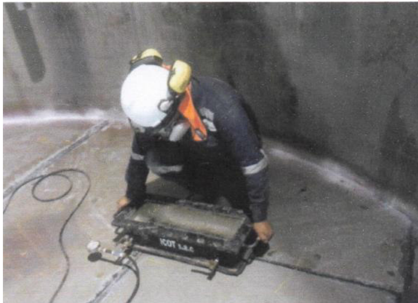
Figura 4.5 Ejecución de prueba de vacío
