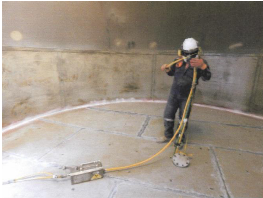
Figura 4.4 Preparativos de prueba de vacío
