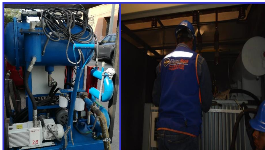
FIGURA N° 18: APLICACIÓN DEL ENSAYO PASO 9
