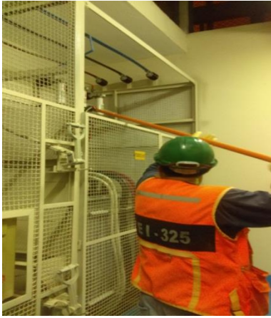
Corte efectivo desde seccionador y revelado de tensión para iniciar labores de mantenimiento preventivo y correctivo.
