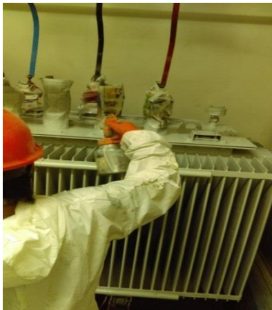
Pintado de transformador de 640 KVA, con color ral 7035 pintura Gloss.
