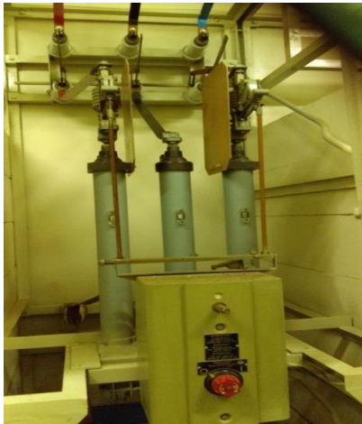
Limpieza de seccionador automático de sede CHUCUITO 1 con trapo industrial y solvente dieléctrico.
