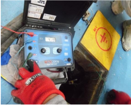
Mantenimiento de pozos a tierra de Media tensión y baja tensión de sede CHUCUITO 1
