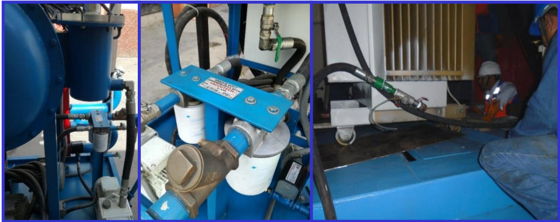
FIGURA N° 13: APLICACIÓN DEL ENSAYO PASO 4
