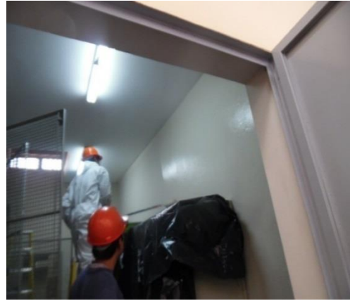
Pintado de techo y pared con pintura vancelatex color blanco decorativo y blanco humo.
