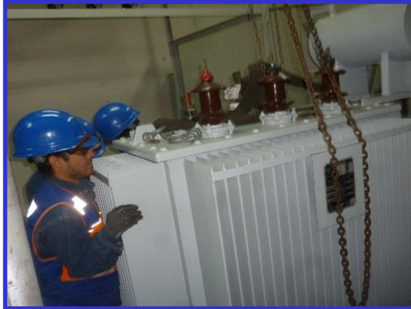
FIGURA N° 11: APLICACIÓN DEL ENSAYO PASO 2
