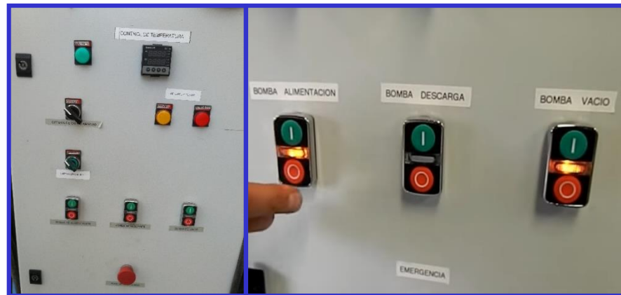
FIGURA N° 15: APLICACIÓN DEL ENSAYO PASO 6
