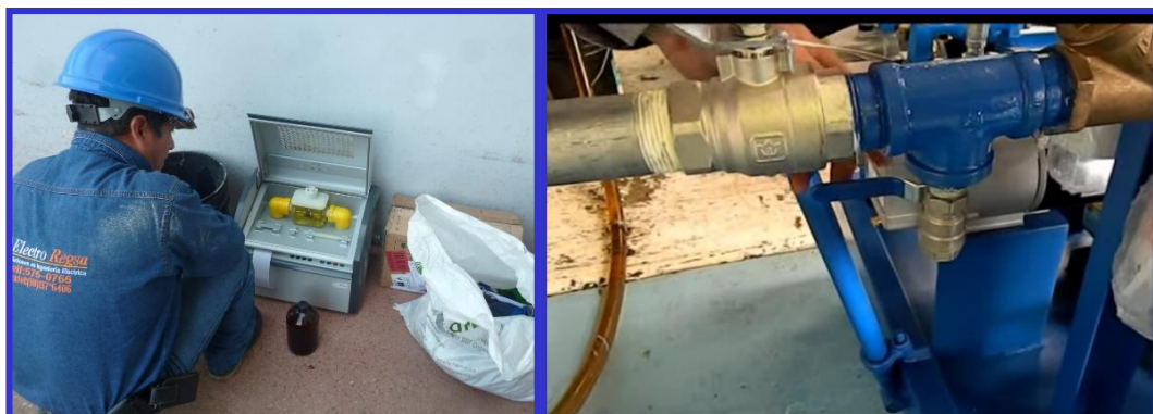
FIGURA N° 16: APLICACIÓN DEL ENSAYO PASO 7
