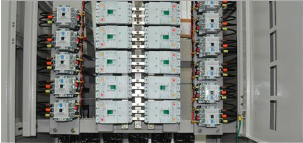
**Fig. 30. Contactores de Protección del Banco de Condensadores**
