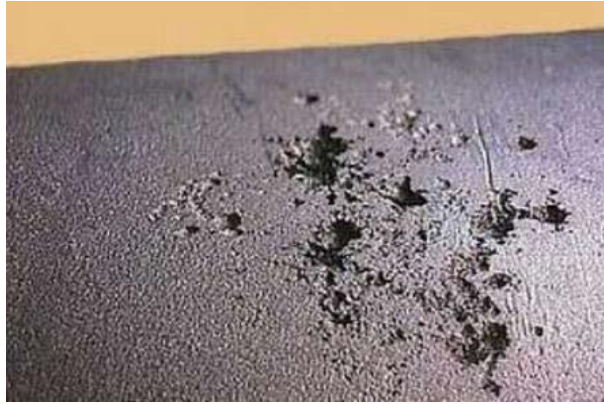
Fig. 2.4 Ejemplo de fotografía de inspección visual
